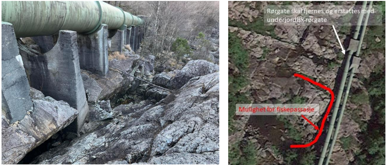
Figur 18. Rørgaten til Grødemfoss kraftverk som skal fjernes i forbindelse med ombygging av kraftverket (venstre) og mulig passasjevei (i samme området som på bildet) for å utvide anadrom strekning av Grødemselva (høyre).
