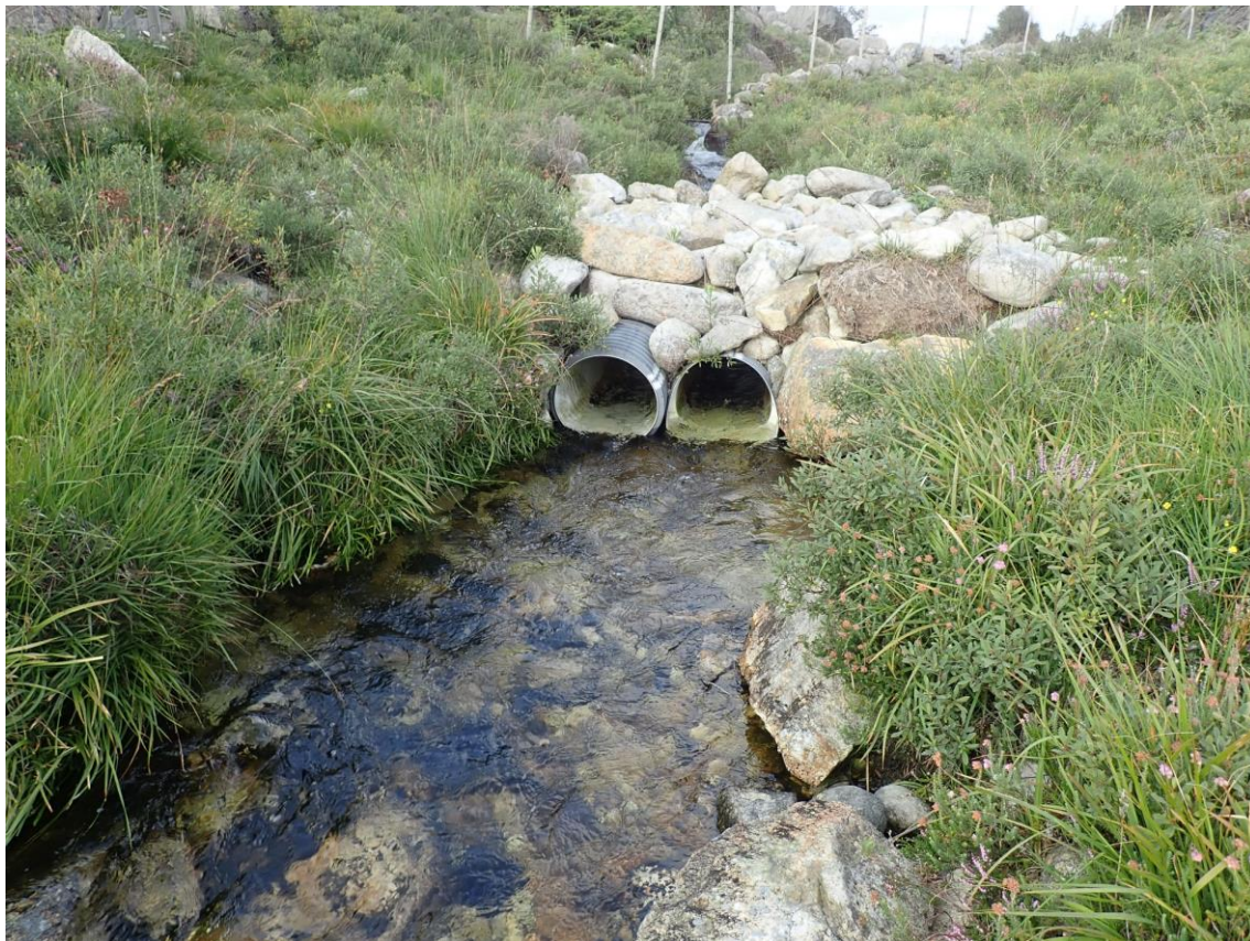
Figur 6. Krysningpunkt hvor bekken er rørlagt over en kort strekning.
