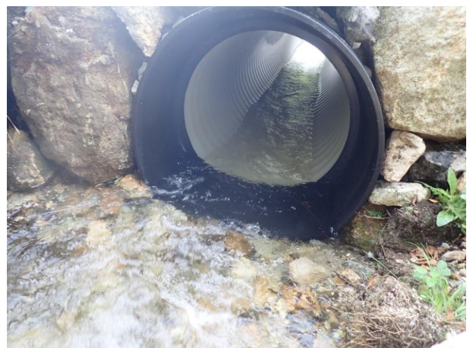
Figur 22. Fysiske inngrep i form av erosjonssikring og et rør som går under veien i nedre del av Legebekken.
