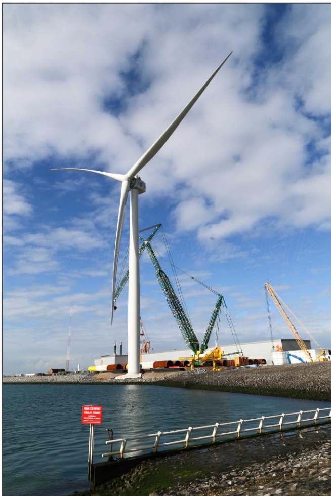
Figur 1-2. GE Haliade-X 12 MW, som har vært under uttesting i Rotterdam havn de siste årene.
