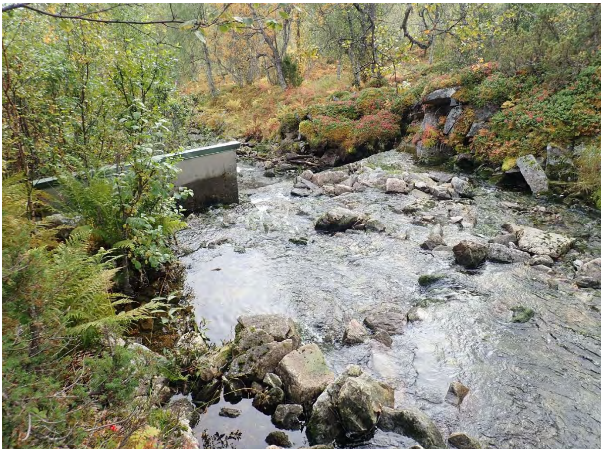
Figur 2. Dam og ventilhus sett fra oppstrøms.
