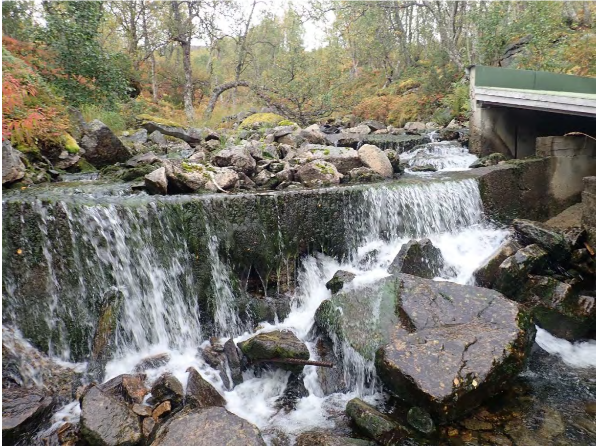
Figur 7. Terskel, overløp og ventilhus
