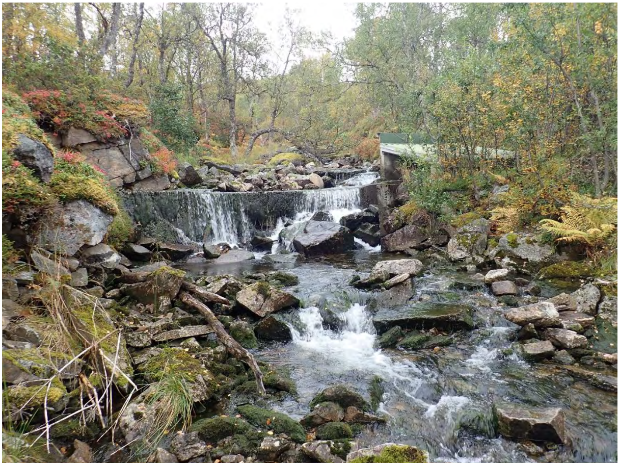
Figur 8. Overløp og ventilhus.
