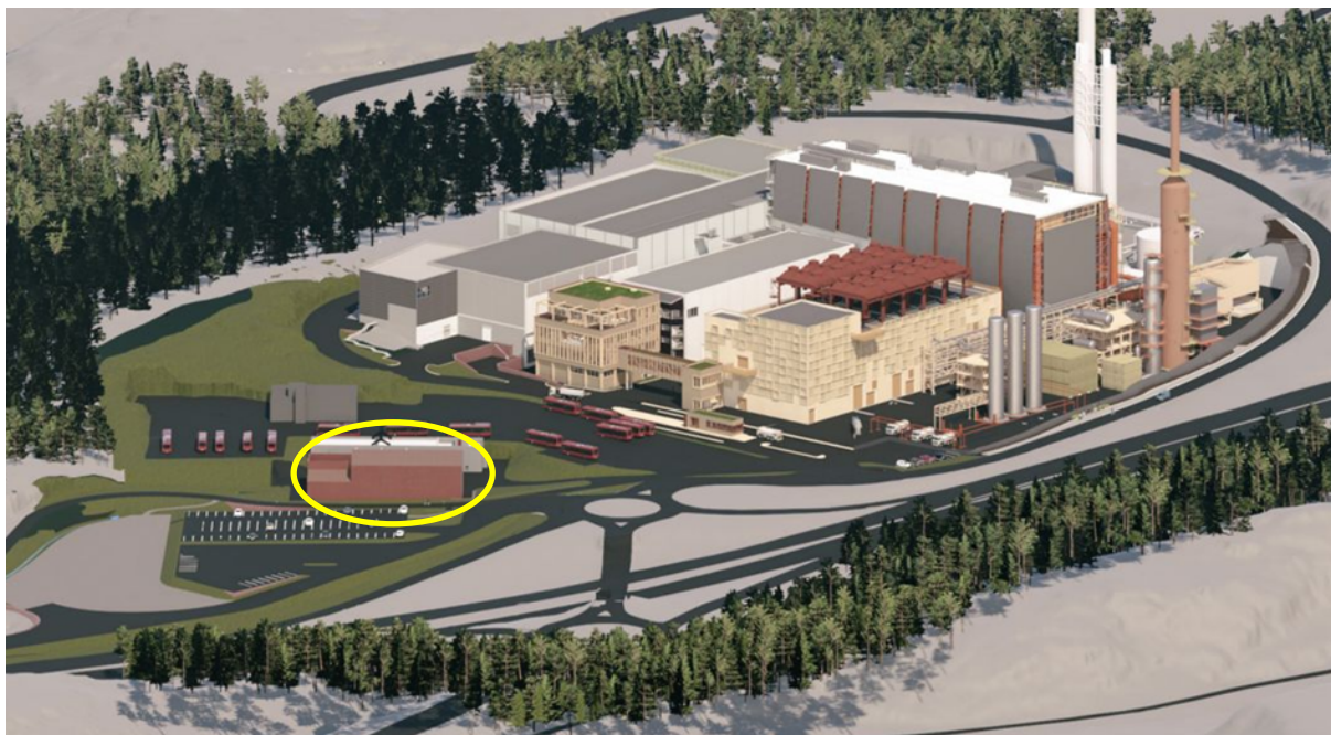
Figur 3: Skisse av utvidelsen av transformatorstasjonen sammen med det planlagte anlegget for karbonfangst og -lagring. Kilde: Hafslund.no. NVE har markert utvidelsen av Klemetsrud transformatorstasjon med gul ring.
