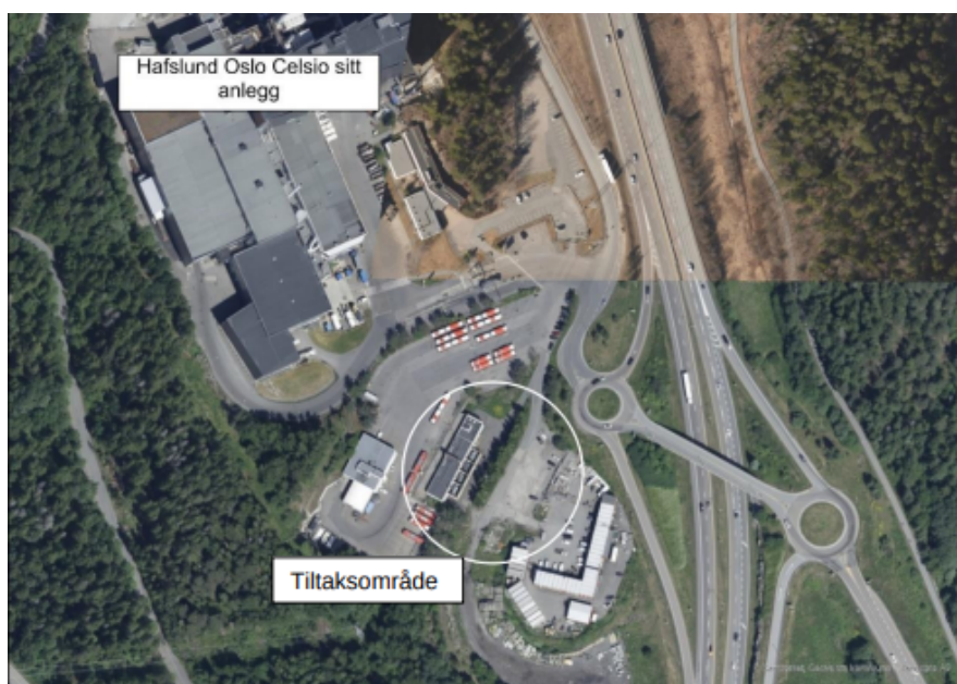
Figur 2: Nytt stasjonsbygg skal etableres i tilknytning til eksisterende transformatorstasjon ved E6 sørøst i Oslo. Kilde: Elvias konsesjonssøknad av 07.02.2024.
