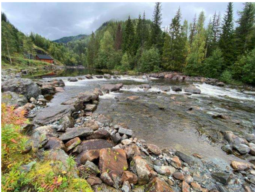
Figur 5-4. Øvre del av delområde 4, med terskler og terskelbasseng/kulp nedstrøms utløpet til Rødberg kraftverk. Foto: Norconsult, 4. september 2024.
