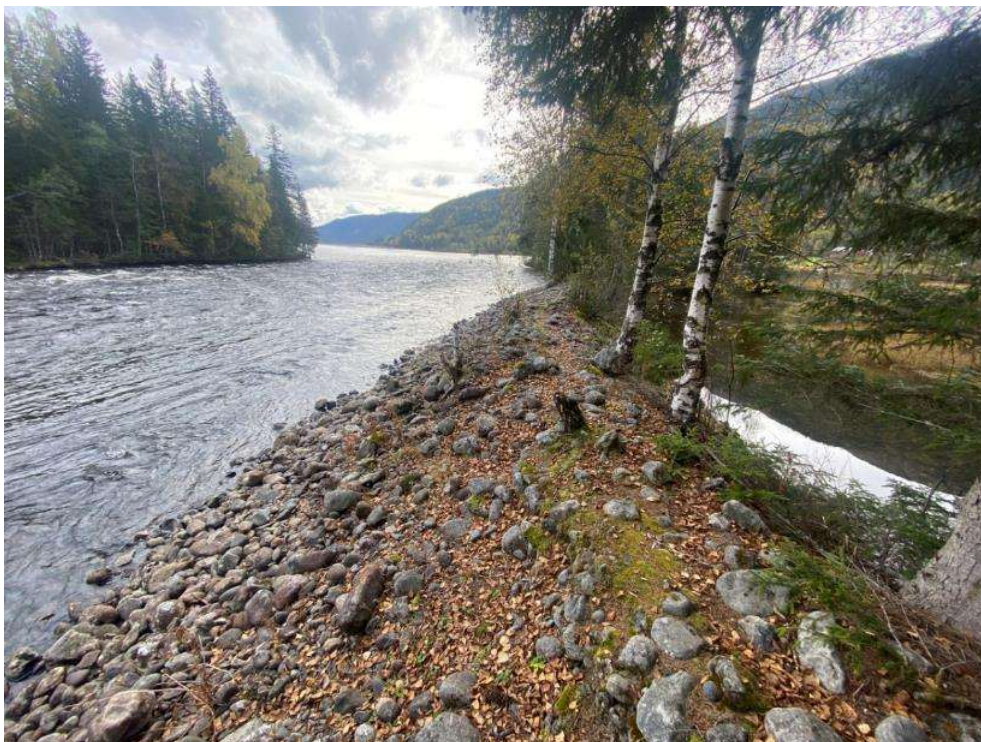
Figur 8-8. Nedre del av Eidsstryken med tilhørende forbygning. Forbygningen spalter opp elvas hovedløp med en evje tilhørende Kravikfjorden, og denne delen av forbygningen har i dag trolig ingen praktisk betydning utover å svekke de økologiske kvalitetene til vassdragssegmentet. Foto: Norconsult, 1. oktober 2024.
