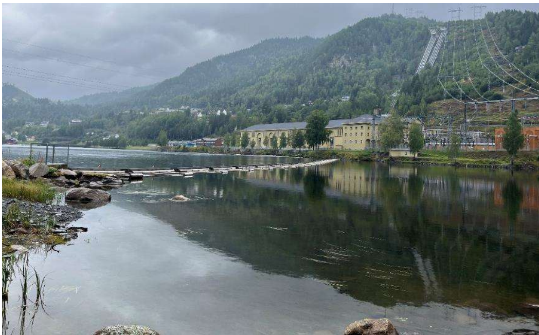
Figur 5-2. Rødbergdammen med Nore I kraftverk. Foto: Norconsult, 20. august 2024.
