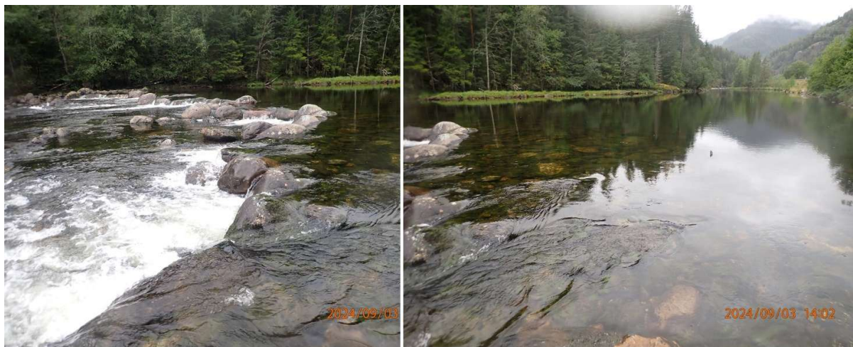
Figur 3-14. Terskel og terskelbasseng i Numedalslågen ved Skjønne.
