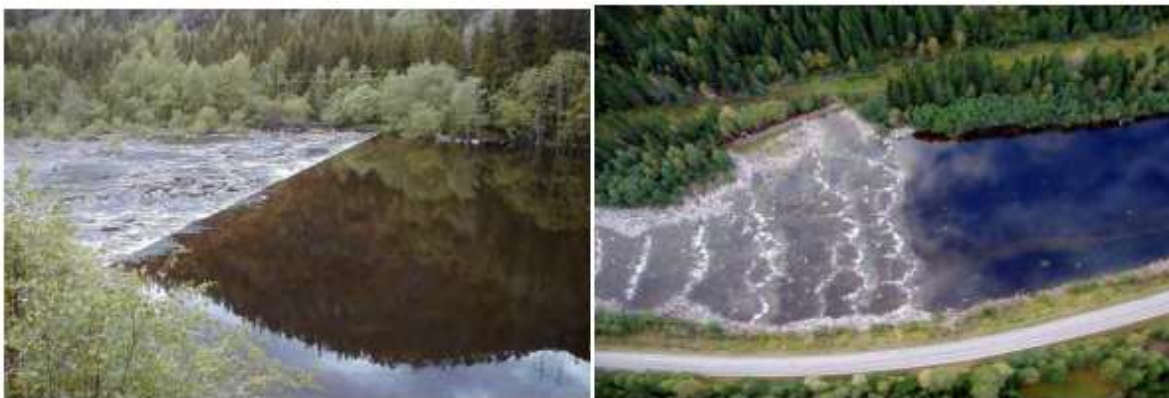
Figur 8-1. Gammel planketerskel (t.v.) og ombygd celleterskel (t.h.) i Numedalslågen mellom Rødberg og Norefjorden. Foto hentet fra NVE-rapport knyttet til evaluering av celleterskler [7].
