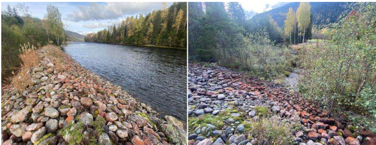
Figur 8-5. Sideløpene i nedre del av Eidsstryken er i dag tørrlagte og avsnørte fra hovedvannstrengen som følge av en massiv langsgående forbygning i Eidsstrykens midtre og nedre del. Foto t.v.: Forbygning oppstrøms beskrevet sideløp. Foto t.h.: Sideløp rett nedstrøms forbygning. Foto: Norconsult, 1. oktober 2024.
