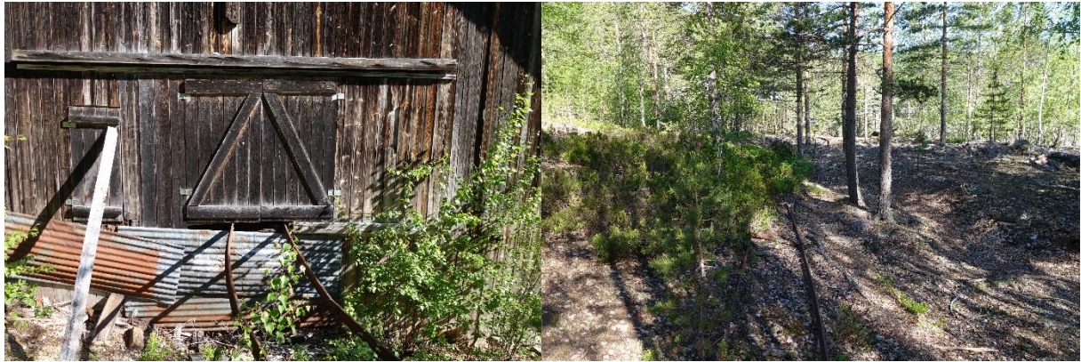
Figur 14. Glomfoss sag, sørenden med skinnegang ut frå huset. Til høgre restar av skinnegangen utover eit område for stabling og lagring av ferdigskoren material.
