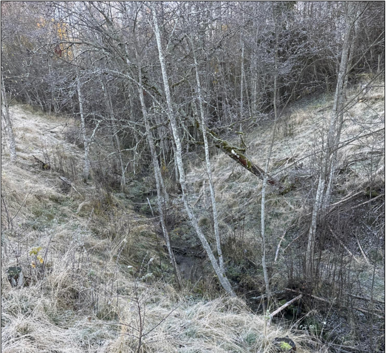
Bilde 62 (noe erosjon)
