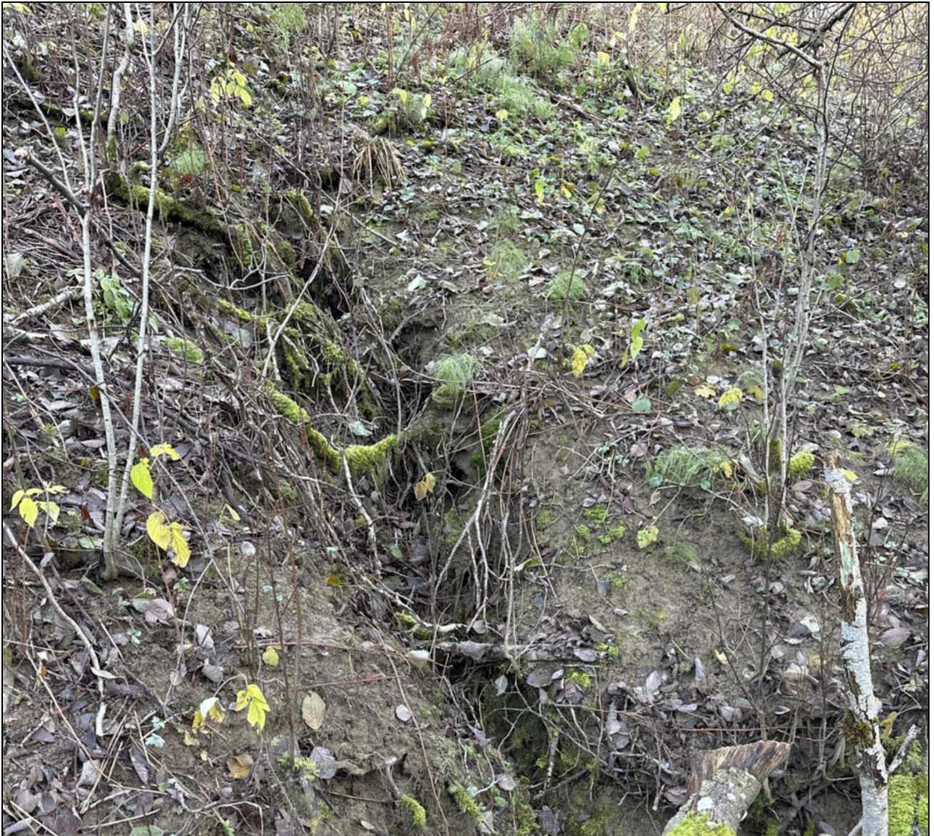
Bilde 69 (noe erosjon)
