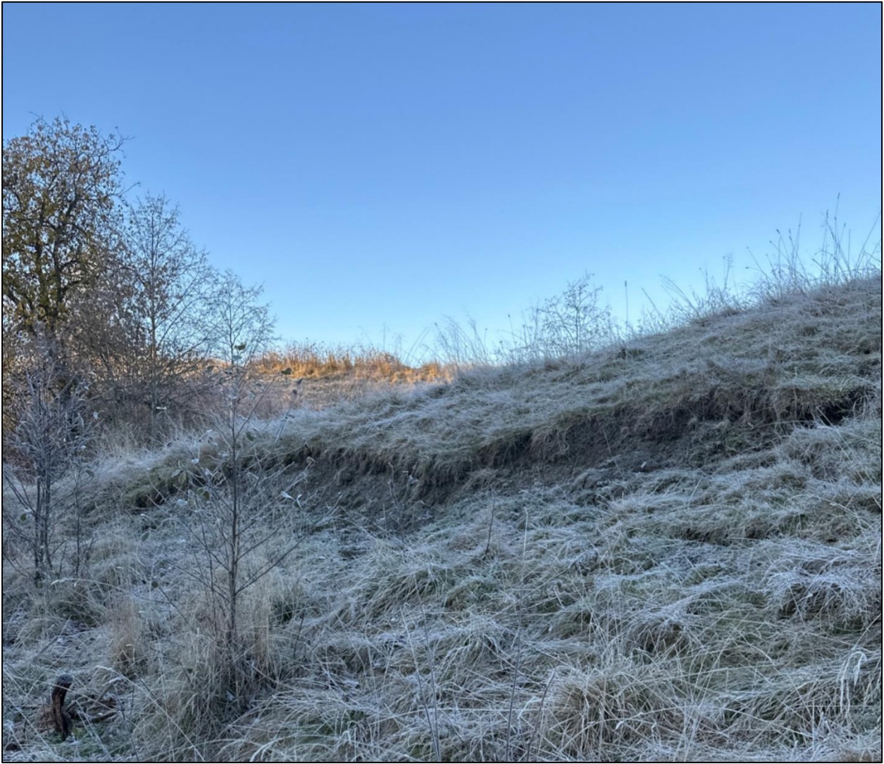
Bilde 64 (noe erosjon)
