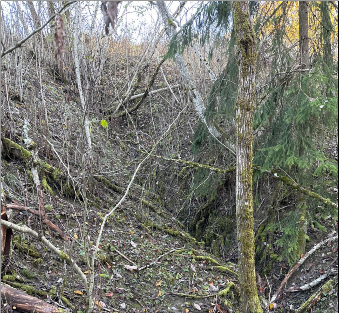
Bilde 67 (noe erosjon)
