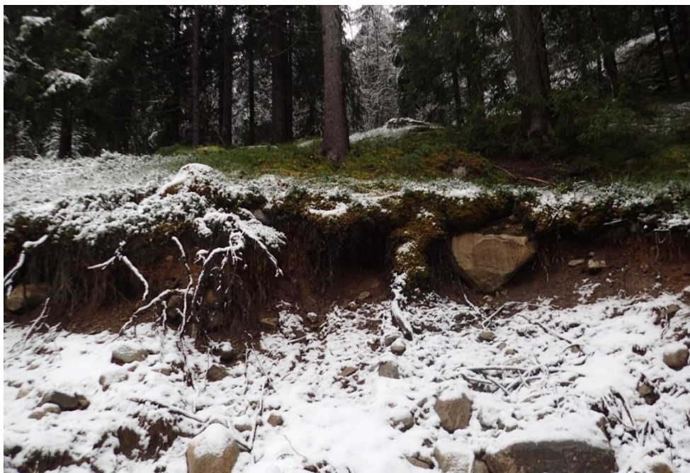
Figur 6. Jordskjæring i nedre del av skråningen. Tydelig morenemasser under vegetasjonen.
