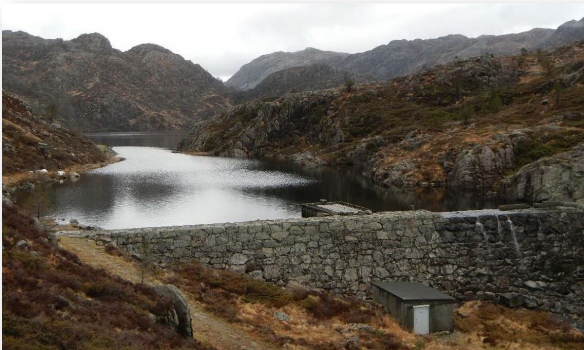
Figur 5 Dam Ravatnet, foto Stord kommune.
