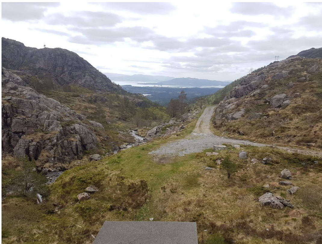
Figur 6 Bilete teke frå dammen i Ravatnet, sett mor søraust, nedover Vatnadalen.
