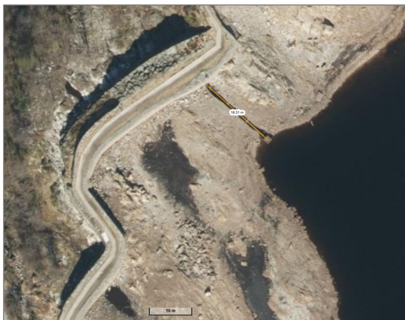
Figur 2. Tapperøret (markert med oransje) ligger omtrent 20 meter fra demningen (dam Storevatnet), og ca. 1 meter lavere enn demningens laveste punkt. Foto: Statens kartverk / Norgeskart.no.
