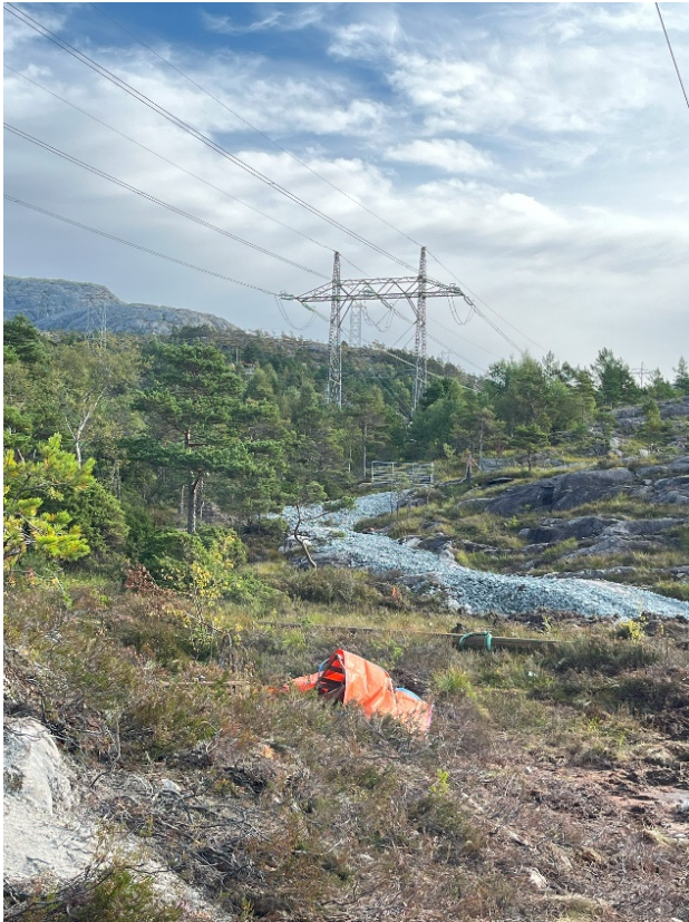
Bilde 4: Gruslagt traktorvei inn til mast (M65T) Foto: NVE
