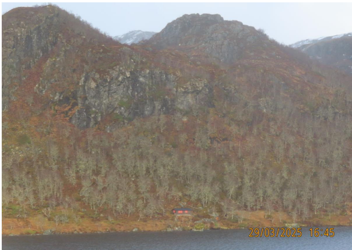
Figur 11 Den 50 meter høye fjellveggen øst for hytten – som utgjør løsnearealet for steinsprang
