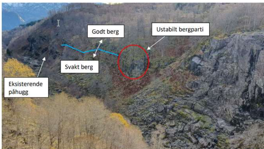
Figur 3-3: Oversiktsfigur utarbeidd av Multiconsult (2024). Framhevar registrert [11] svakt berg på vestsida elva.
