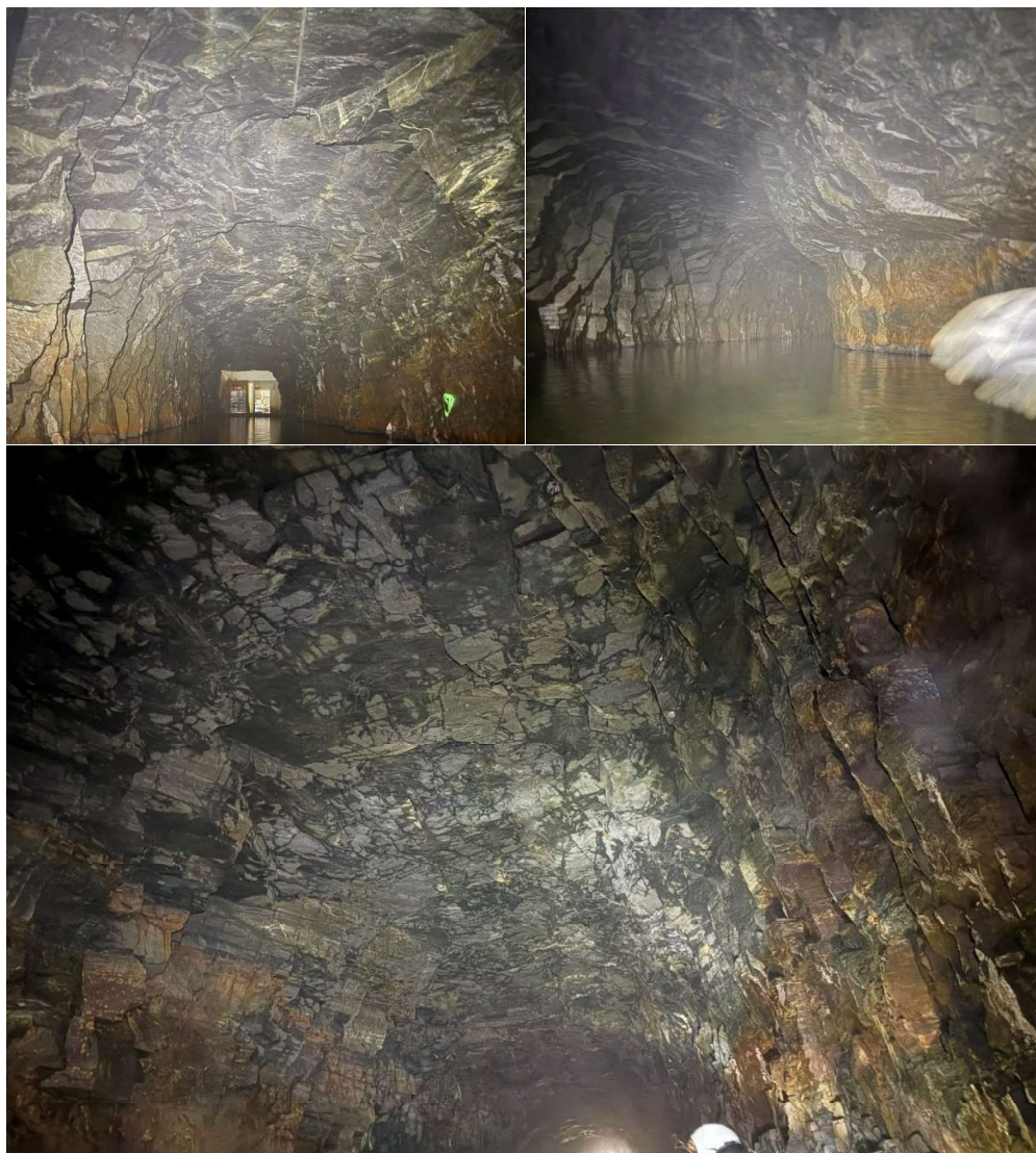
Figur 2-6: Observasjonar av bergmassen i eksisterande tunnel. Øvst til venstre foto teke i retning eksisterande luker og sjakt. Øvst til høgre teke nedstraums sving og tilbake mot luker. Nedst viser parti med høgare oppsprekkingsgrad i eksisterande tunne sett mot utløp, estimert omlag. 50 meter frå utløp.
