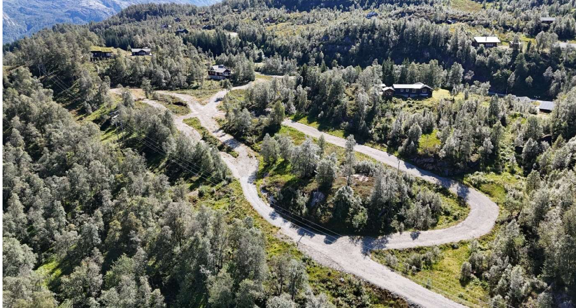
Figur 4-9: Oversiktsfoto som viser kolle lokalisert ca. 70 meter frå sving i tunnel.
