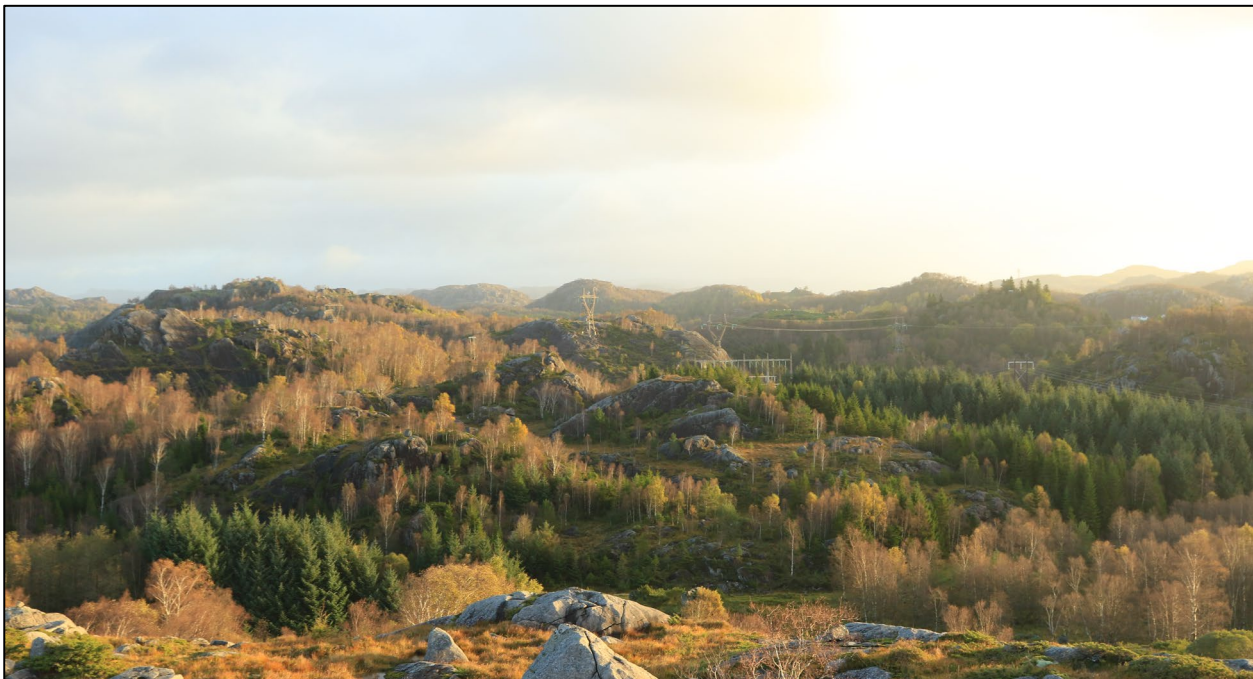
Figur 31 Skogkledte bergkoller i et småknudrete og rotete relieff med ledningsnett til og fra Kjelland transformatorstasjon.
