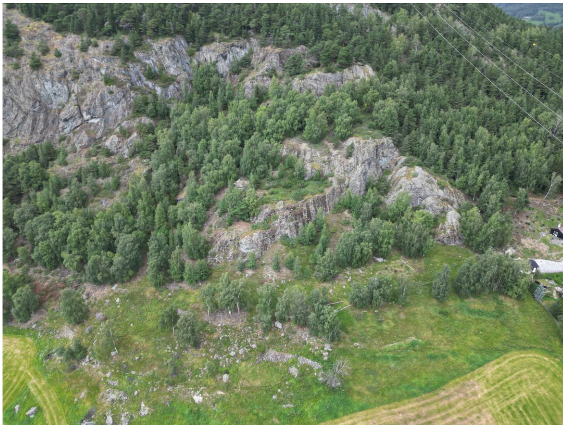
Figur 4. Løsneområder for steinsprang øst for Vangsbergje. Antatte steinsprangavsetninger nedenfor bergskrentene. Bildet er tatt med drone mot nord/nordvest.
