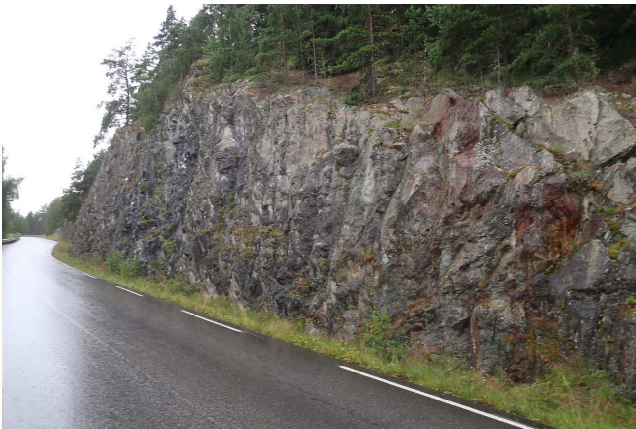
Figur 9. Utsprengt skjæring langs FV2634.
