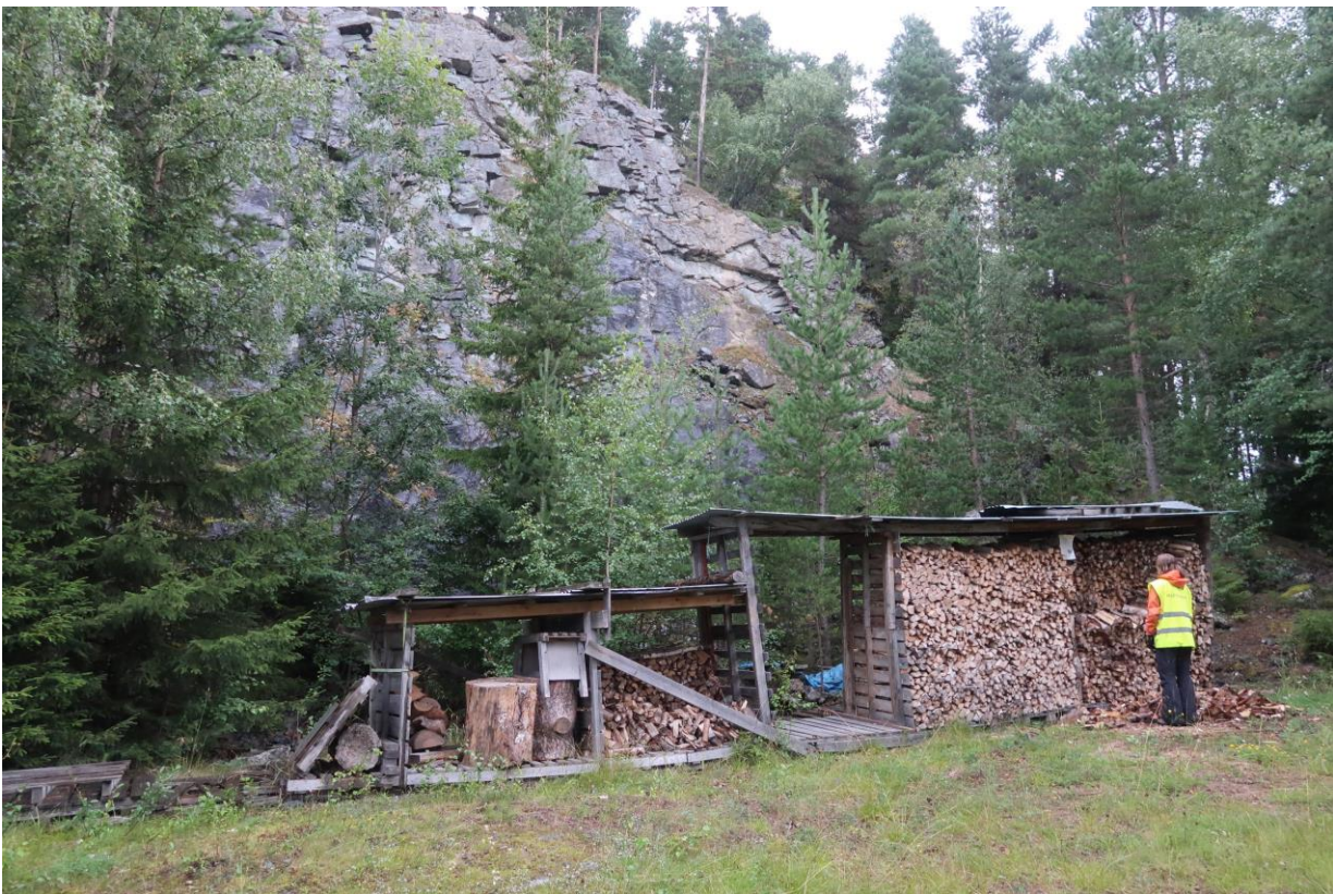
Figur 7. Bergskrent i det nordligste kartleggingsområdet bærer preg av tett oppsprekking.
