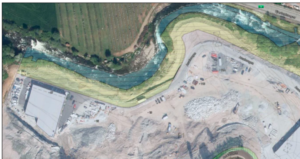
Figur 10: utsnitt frå Sogndal kommune sitt planregister. Bildet viser at muren mot elva og deler av veg er etablert utanfor formålsgrensa i reguleringsplan Nedrehagen – Kvåle bru. Bildet er henta frå søknaden som viser til www.kommunekart.no .
