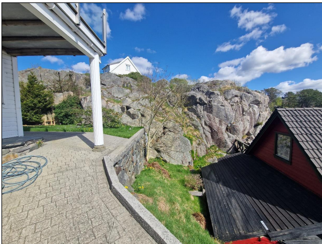
Figur 3. Oversiktsbilde av skråningen/brattskrenten sør i kartleggingsområdet. Bilde tatt mot nord.
