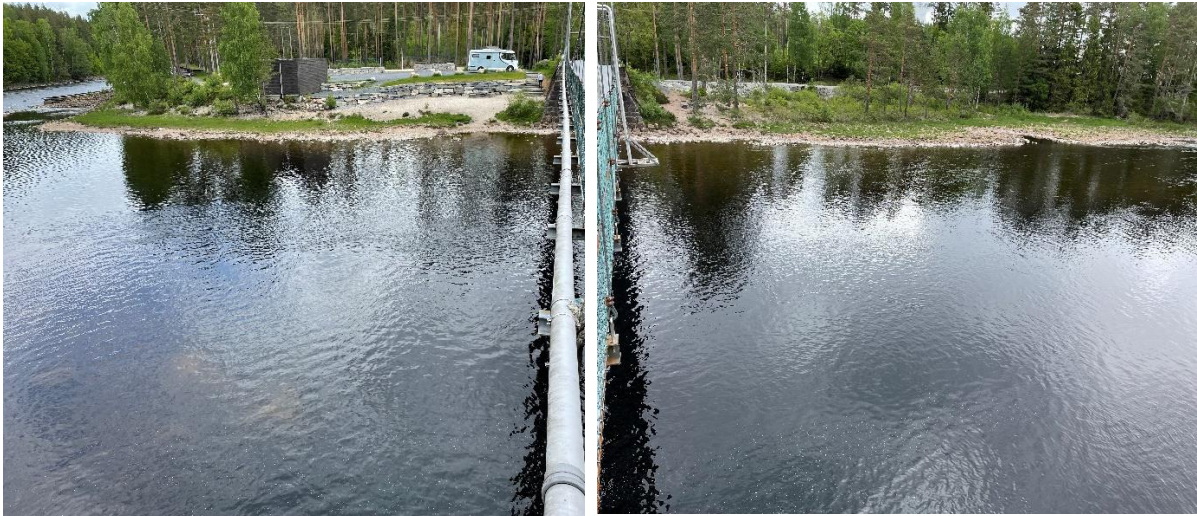
Foto 31.5.2022 (både oppstrøms og nedstrøms hengebroa)
