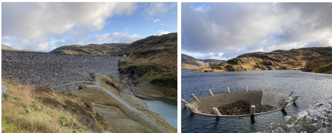
Figur 7-21: Dam Askjeldalsvatn (venstre) og overløp til dammen (høyre)
