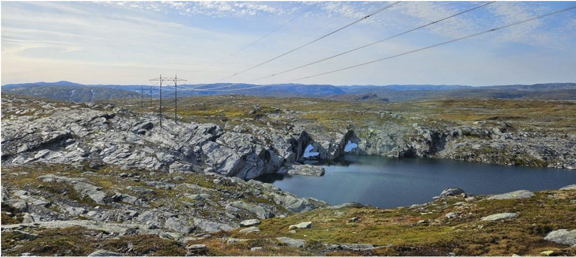
Figur 5-5: Vetle Katlavatni med eksisterende kraftledning mot vest
