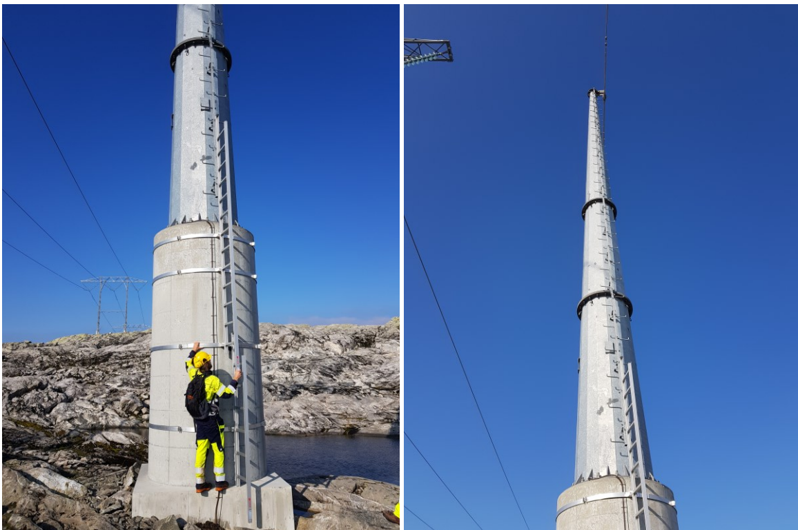
Figur 3-2: Tilsvarende løsning for monomaster parallelt med kraftledning (bilde er fra 300 kV Steinsland–Haugsvær). Foto: Statnett
