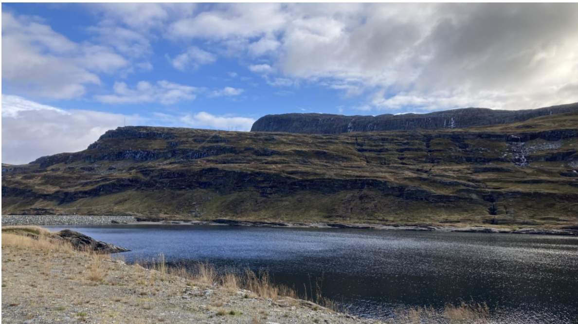
Figur 7-22: Parkering ved inngangen til Stølsheimen landskapsvernområde (øverst til venstre). Utsikt mot landformer rundt Kvilesteinsvatnet (øverst til høyre). Utsikt mot Katladalen og Skjellinganosi med dammen i forgrunnen til venstre
