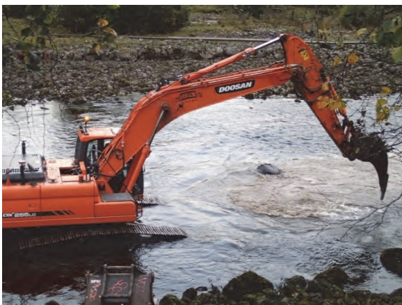
Bilde 6-5: Harving med ripper for å etterligne rensing av substrat ved flommer (Bilde lånt fra LFI-rapport 296/2018)
