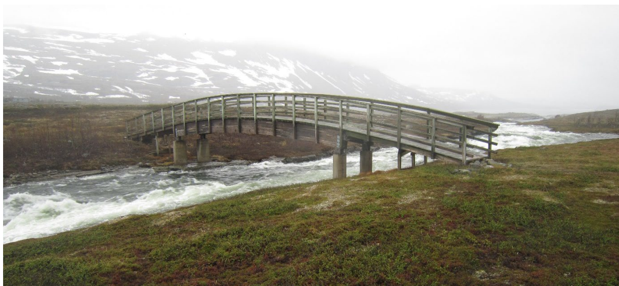
Bilde 5-2: Bru Roggejávri under flomvannføring (bilde tatt fra vest)
