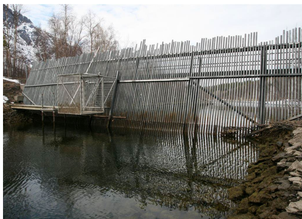
Bilde 5-4: Fiskesperre, lysåpning 45 mm
