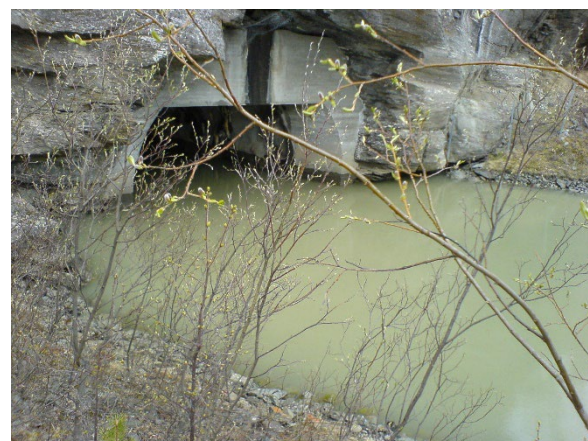
Bilde 6-4: Turbin vannføring (avløpskanalen) blakket av bunnsedimenter fra Rihpojávri nær LRV
