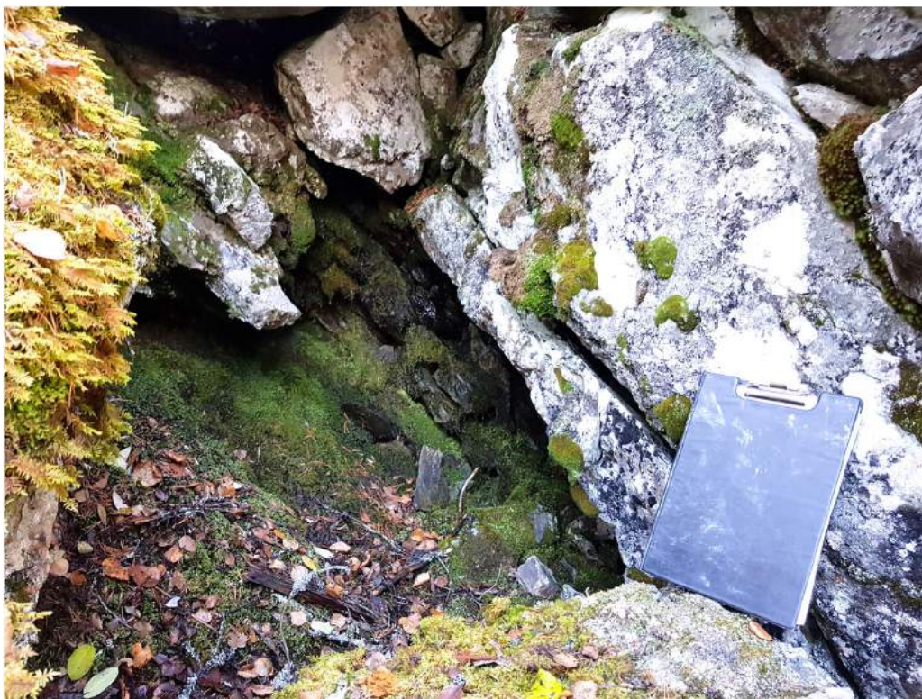
Bilde 2-4 Redusert avstand mellom sprekker i svakhetssonen nærmer planlagt kraftstasjon. Bilde er tatt på basis av skråning vist i Bilde 2-1.
