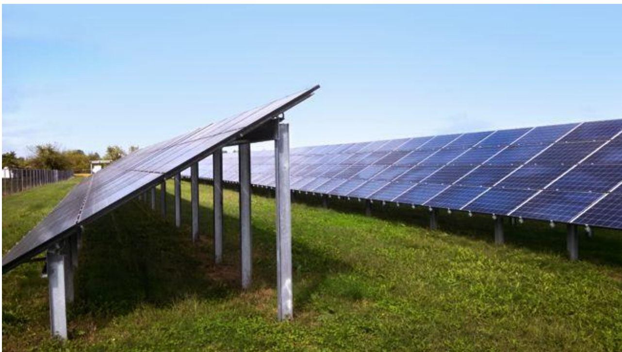
Figur 3-1: Fast-vinkel installasjonsløsning (foto: Willowbrook Solar).
