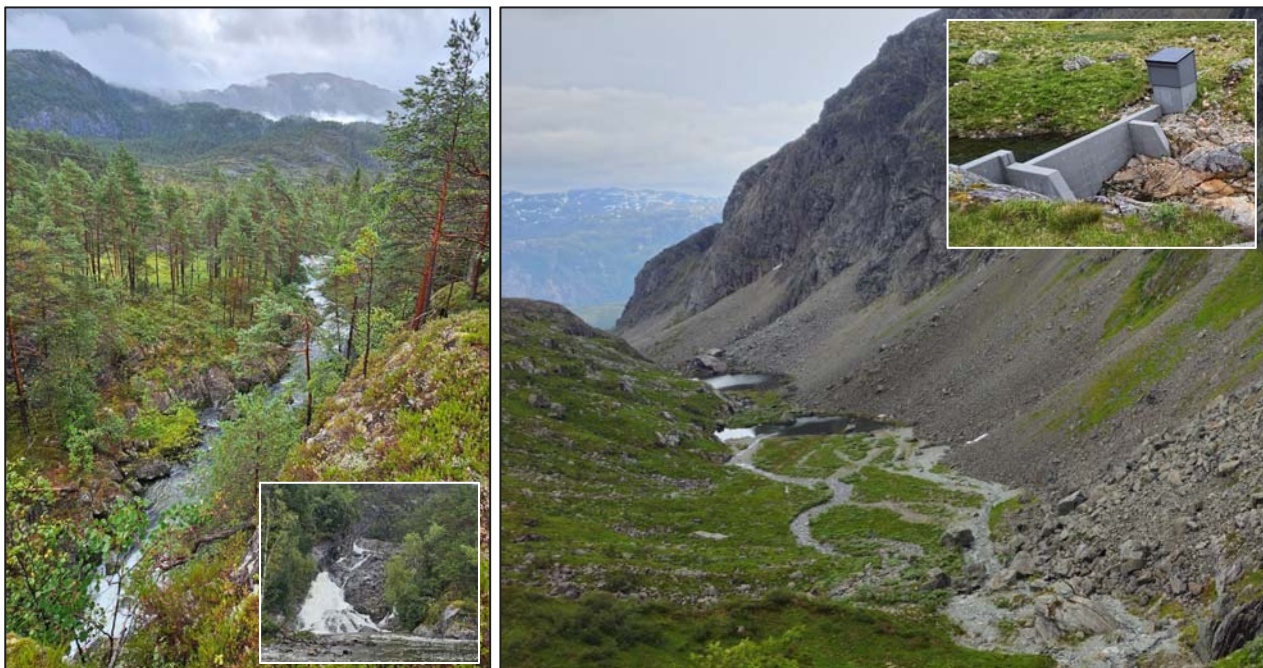
Figur 3-6 Vannforekomsten Eikemoelva nedstrøms inntak Blåfalli III H , t.v. nedstrøms Eikemo og t.h. Skreddalen. Innfelt bilde opp til høyre viser demningen ved utløpet av Tjørndalsvatna oppstrøms Skreddalen. Innfelt bilde nede til venstre viser Eikemoelva ved utløp sjø. Foto: M. Bjerga, Multiconsult.
