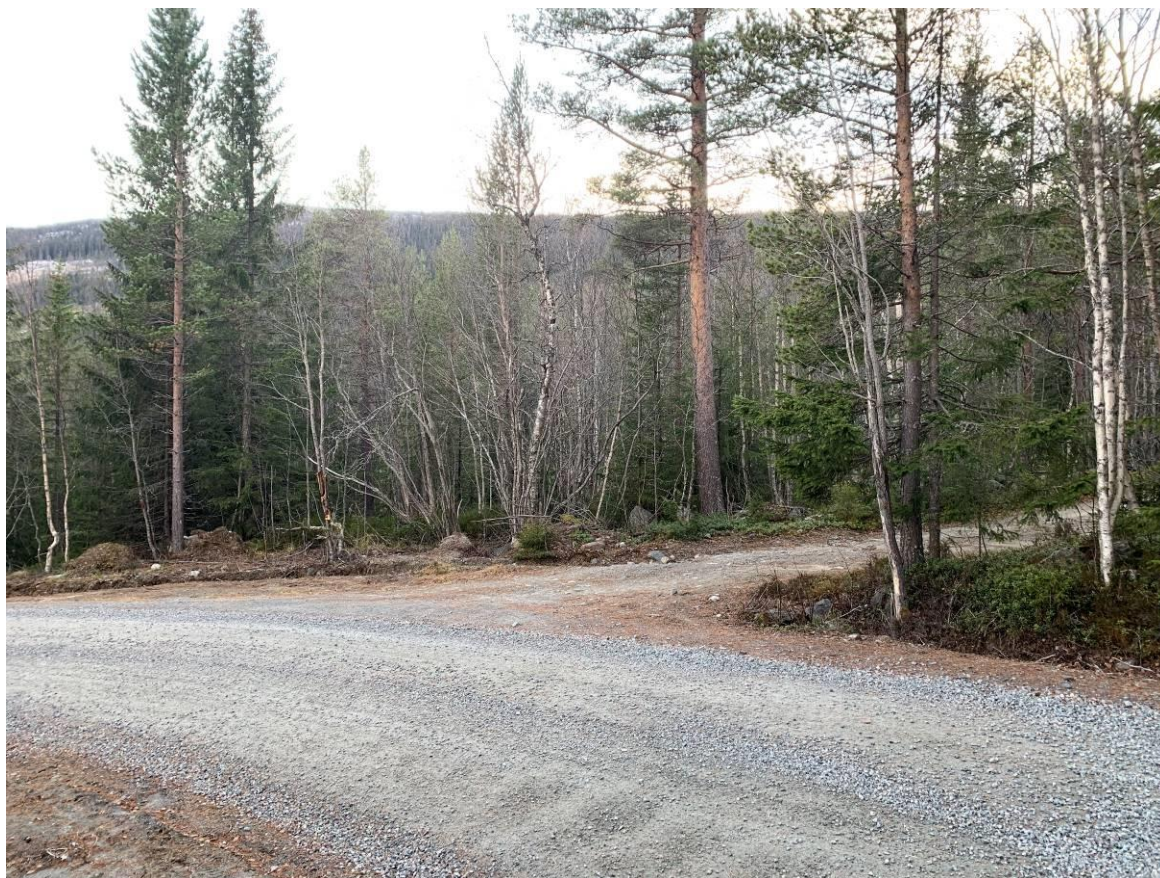
Bilde 3.1 Avkjøring til stasjon ca kote 635 moh (NB elva er ikke synlig selv uten løv)
