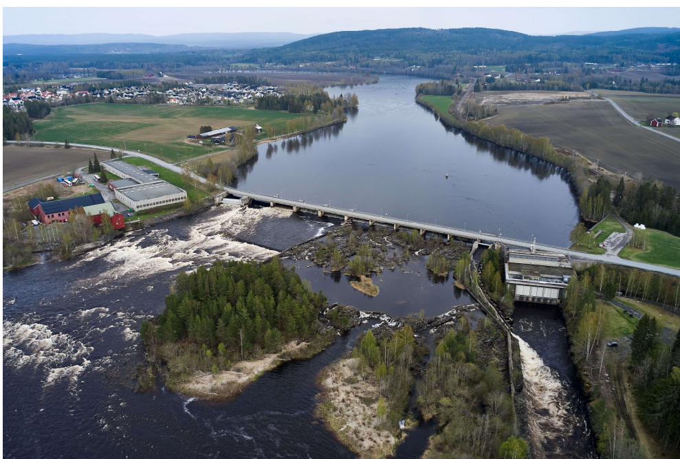
Bilde 2 Funnefoss sett nedstrøms dam med kraftstasjon og utløpskanal til høyre i bildet
