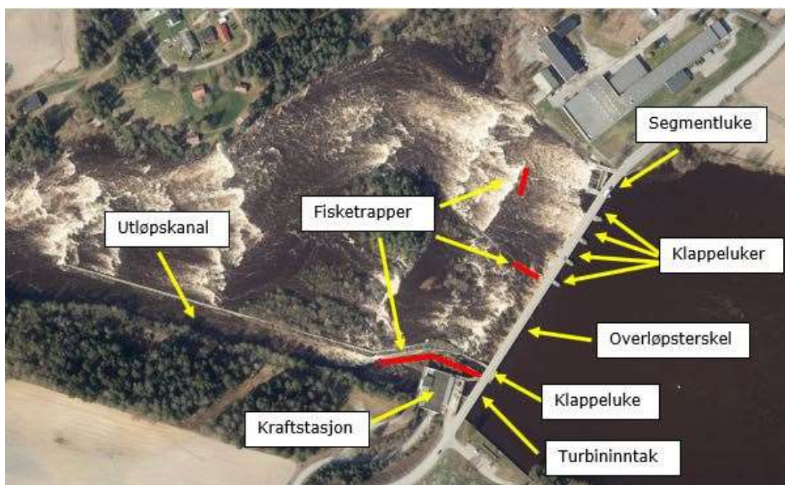
Figur 3 Oversikt over Funnefoss kraftverk og damanlegg
