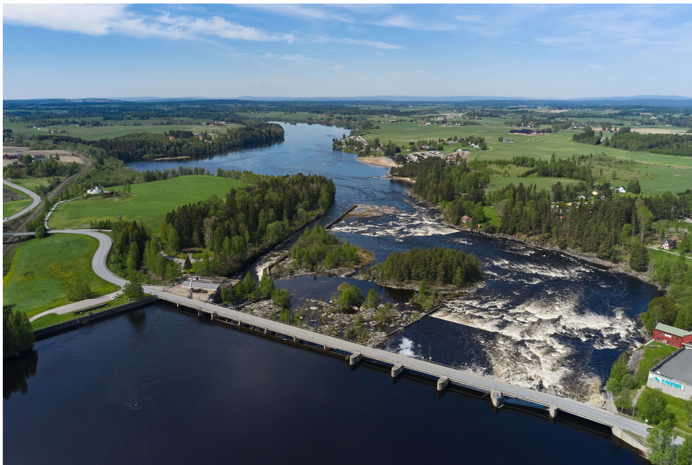
Bilde 1 viser dam Funnefoss sett oppstrøms dammen, flomløpet til høyre i bildet
