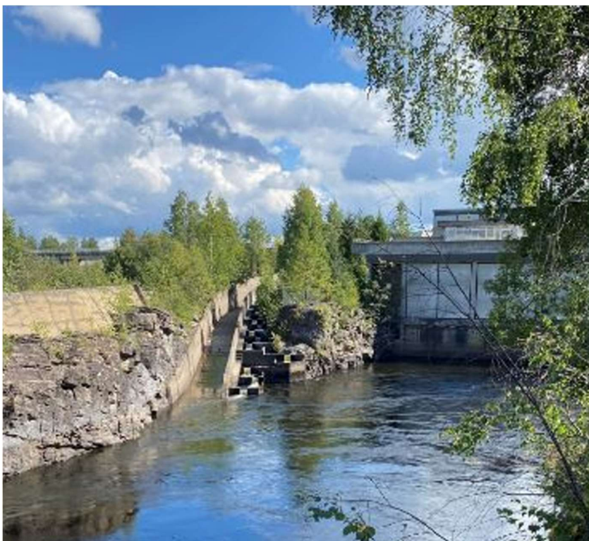
Bilde 1 Viser nedre del av fisketrappa som ligger ved siden av kraftverksutløpet, til høyre.
