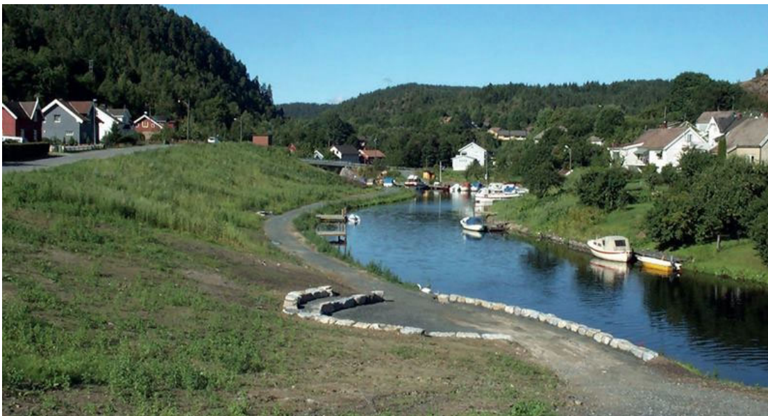
Figur 3. Bilde etter utførelse av sikringstiltakene 2000-2003, tatt fra Coop Prix butikken og i retning oppstrøms Herreelva, [5].
