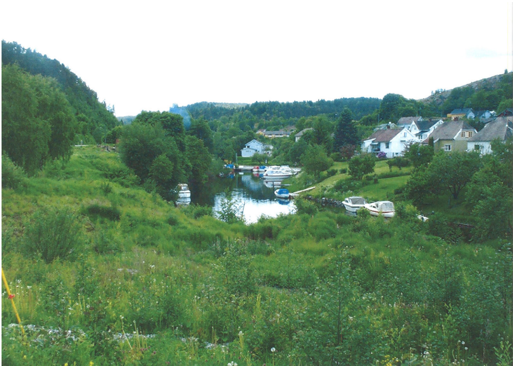
Figur 2. Bilde innen utførelse av sikringstiltakene 2000-2003, tatt fra Coop Prix butikken og i retning vest oppstrøms Herreelva, [1].
