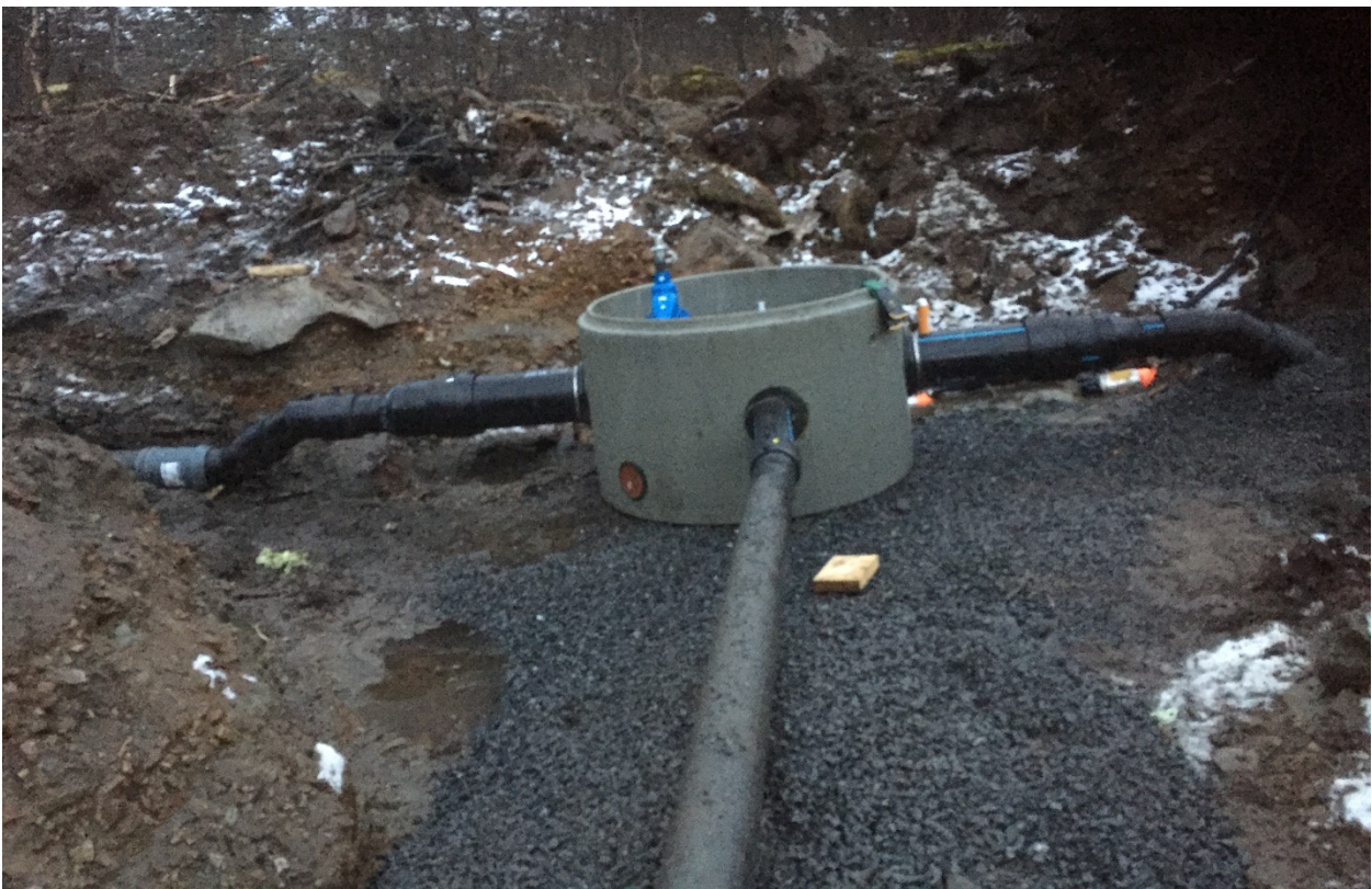
Figur 4 Påkoblingskum for eksisterende vannledning
