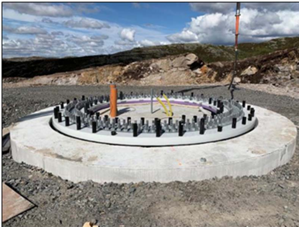
Figur 2-3. Turbinfundament og tårn i Tonstad vindkraftverk etter innfylling av masser. Foto: Tonstad Vindpark AS.
