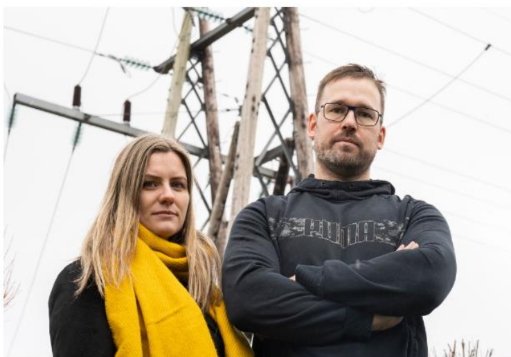
UBEHAGELIG: May-Lene Wold Svendsen og Frank Svendsen føler seg utrygg av å bo så tett på det elektriske anlegget. Foto: Kent Olsen
