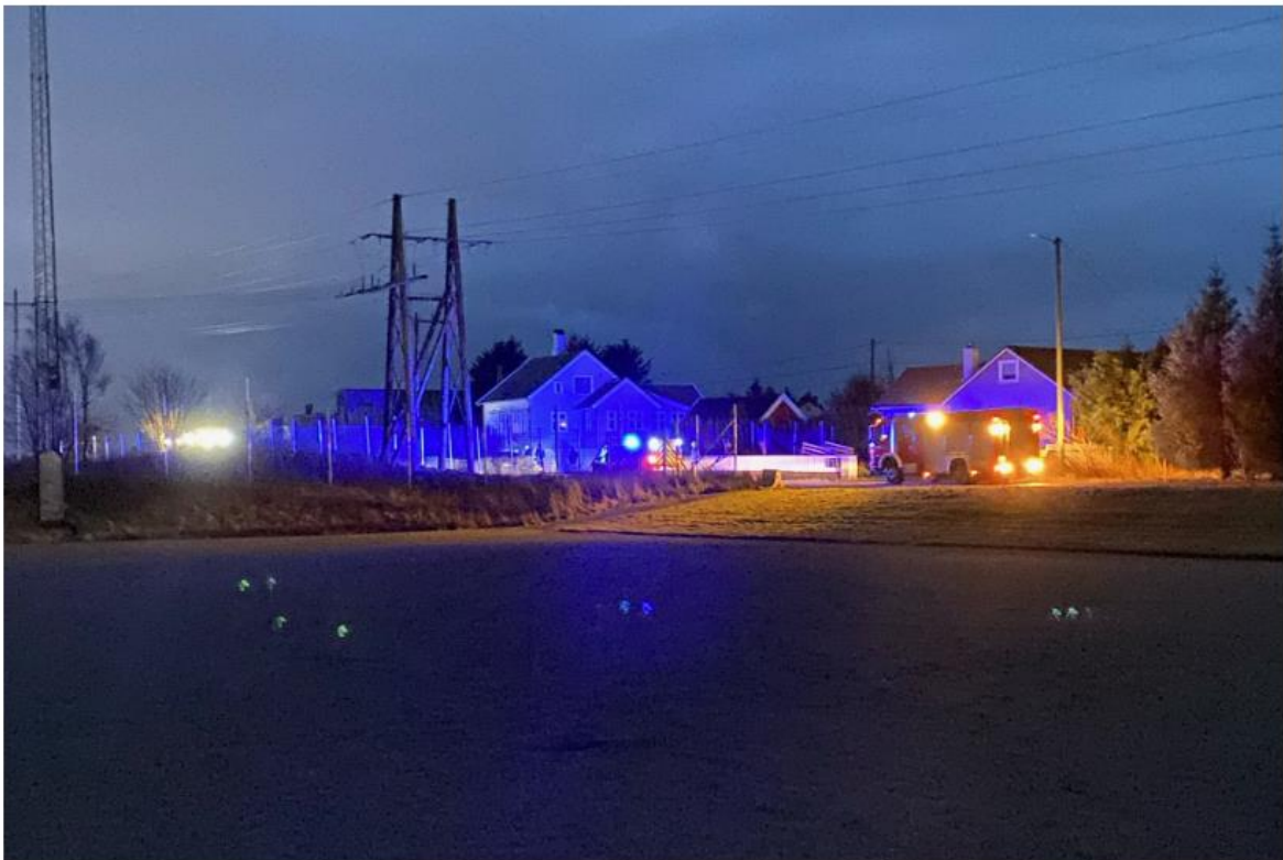
BRANNVESEN: Brannvesenet rykket ut til melding om brann i en trafostasjon på Bø. Foto: Ella Hausken
