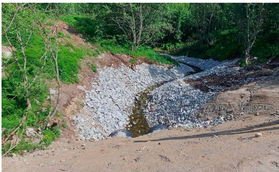
Figur 4: Erosjonssikring ved innløpet.
