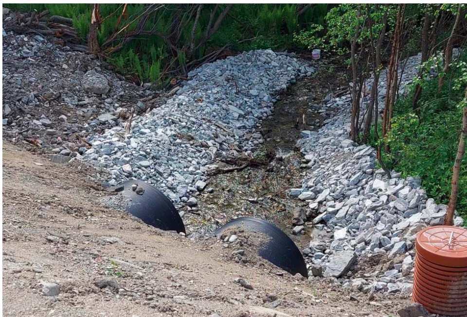
Figur 5: Erosjonssikring ved utløpet.
