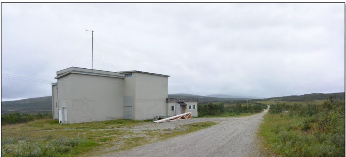
Figur 4-32. Smørffjord transformatorstasjon før utvidelse.
