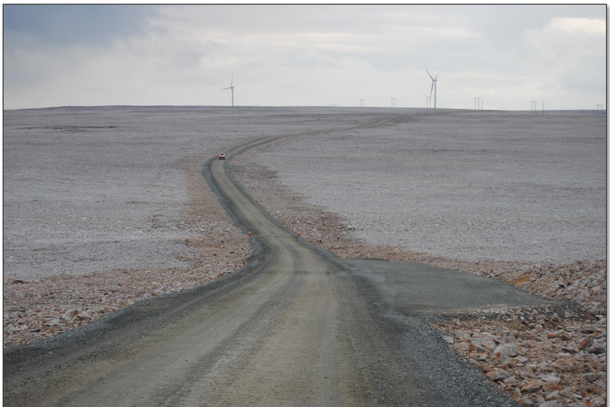
Figur 2-4. Adkomstvei til Raggovidda vindkraftverk. Forholdene på Sandfjellet og Koifjordfjellet er veldig like det man finner på Raggovidda, så dette bildet gir et veldig godt inntrykk av hvordan det vil kunne se ut innenfor planområdet etter en eventuell utbygging. Foto: Multiconsult Norge AS.
