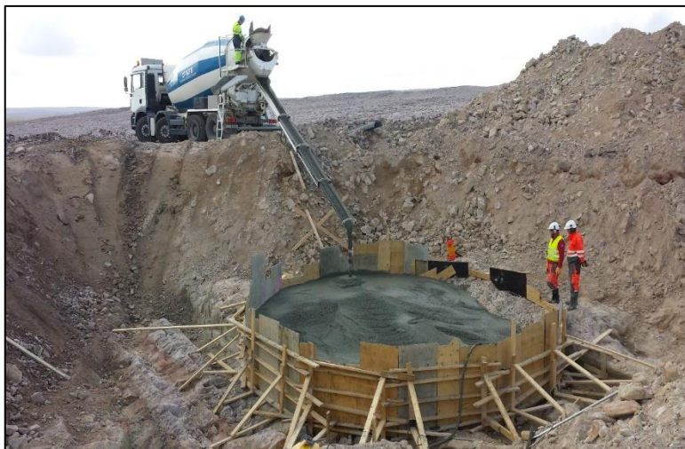
Figur 2-2. Støping av turbinfundament i Raggovidda vindkraftverk. Mest sannsynlig vil det bli valgt samme type fundament på Sandfjellet. Foto: Multiconsult Norge AS.
