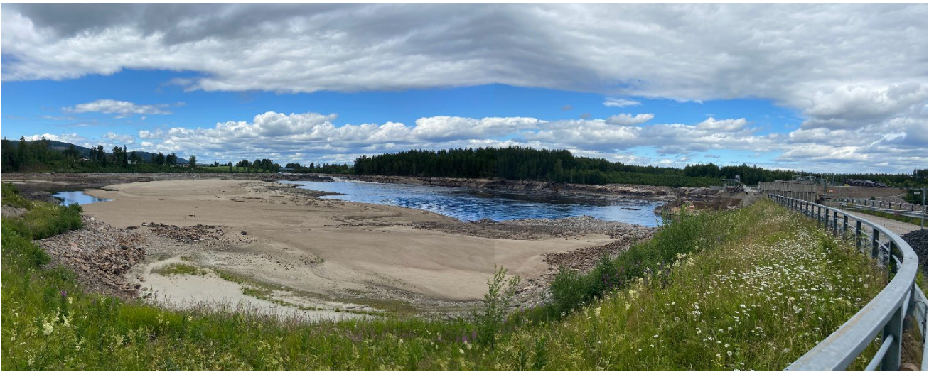
Figur 2. Tørrlagt elvebunn i inntaksbassenget til Braskereidfoss kraftverk. Dam og kraftverk sees i høyre bildekant. Like utenfor venstre bildekant er en avsats i elveskråningen hvor det planlegges å anlegge sedimentasjonsbasseng for sedimentering av slammet lekkasjevann fra byggeplog. Bildet er tatt 1. juli 2024 med vannføring på ca. 200 m 3 /s målt ved Elverum.
