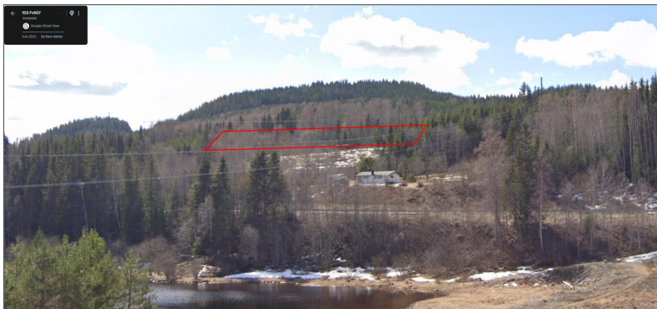
Figur 3 Omtrentlig lokalisering av uttaksområdet markert med rødt polygon, sett fra Fv. 507 som går over fyllingsdammen (Google Street view).
