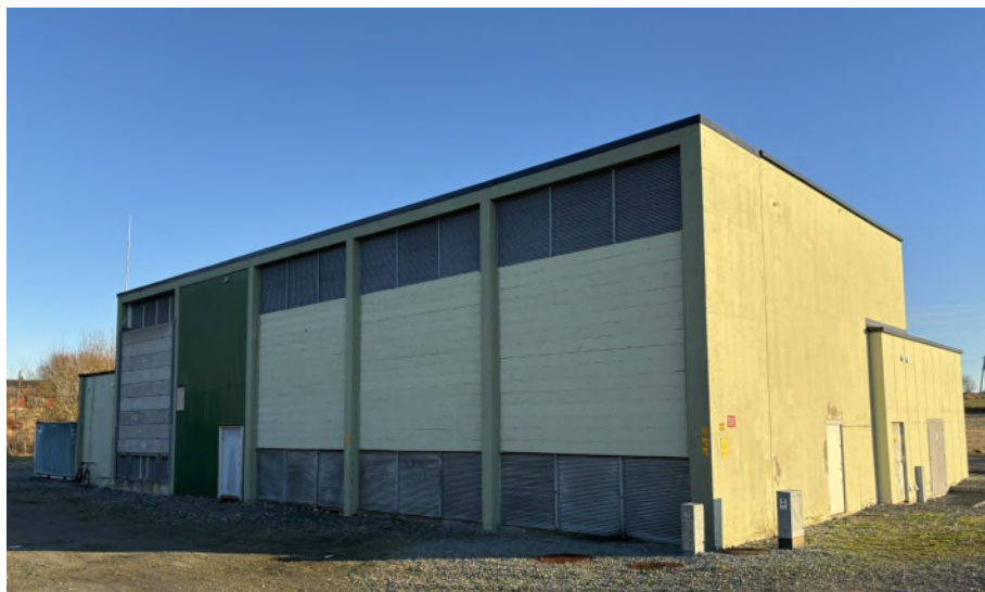
Figur 5-5. Bilde av eksisterende Risavika transformatorstasjon fra september 2024.
