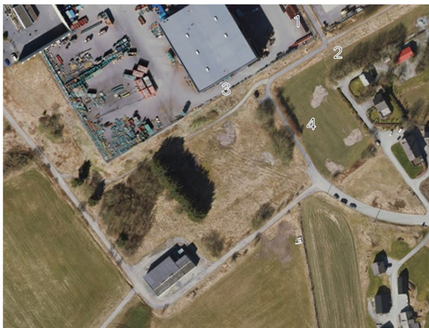
Figur 5-7. Dagens situasjon for gang- og sykkelveg som passerer stasjonstomta langs nordsiden og østsiden. Ved industriområdet er eksisterende veg asfaltert (1). Frem mot krysset til den asfalterte delen (2) er gang- og sykkelvegen
