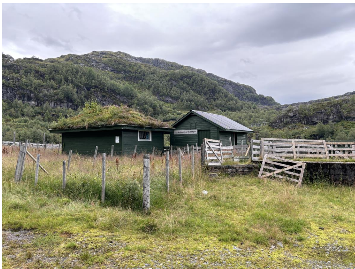
Figur 15: Bygningene og gjerder som Ytre Midthordland beitelag benytter i forbindelse med saueslipp og sauesanking.
