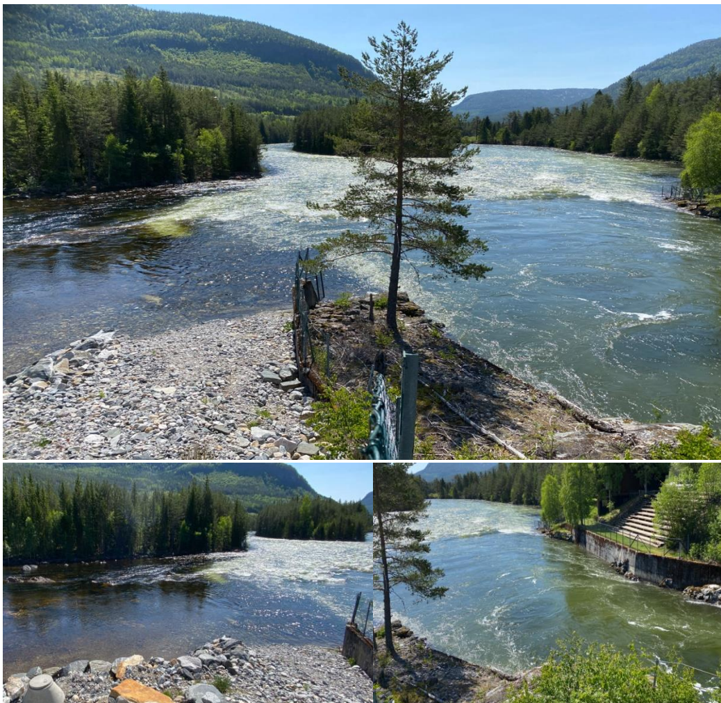
Figur 12. Episode med gassovermetta vatn ut av Brokke kraftverk kl. 12:00 den 5. juni 2023. Bilde viser «blakka» vatn ut av tunell til høgre og «reint vatn» frå minstevassføringa til venstre.
