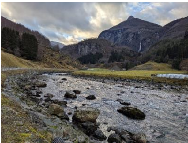
Figur 13 Venstre: Eksempel på stein lagt ut i elven foran erosjonssikringen i Flåmselva. Høyre: Damplastring med stein lagt med lengdeaksen innover i bakken og med en ru overflate. Bilde hentet fra Sikringshåndboka, NVE 2021
