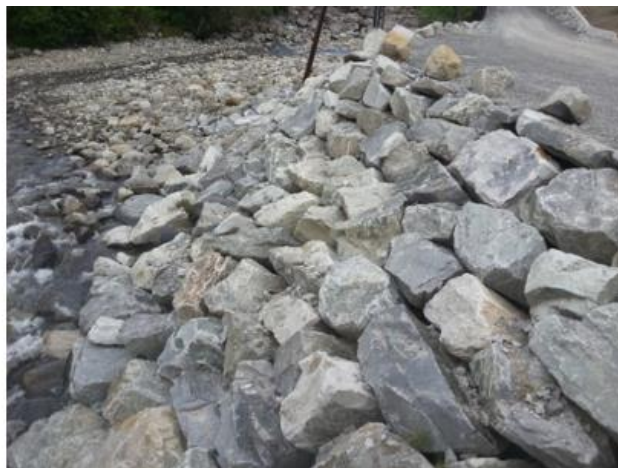
Figur 13 Venstre: Eksempel på stein lagt ut i elven foran erosjonssikringen i Flåmselva. Høyre: Damplastring med stein lagt med lengdeaksen innover i bakken og med en ru overflate. Bilde hentet fra Sikringshåndboka, NVE 2021
