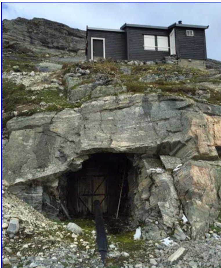
Figur. 3.15.11. Utløpet til den gamle tappetunellen med stengsel og taperøyr.
