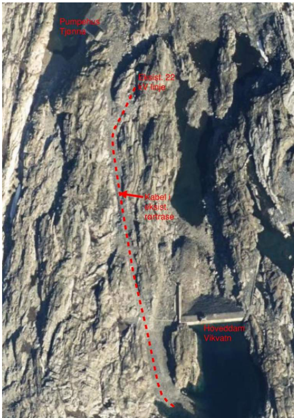
Figur 3.15.8. 22 kV kabel i eksisterande rørtrase
