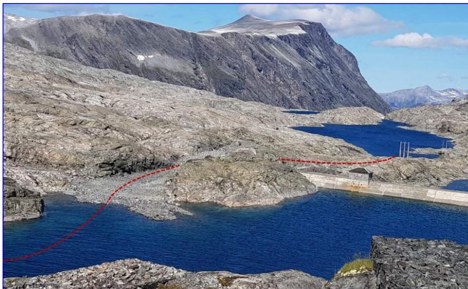
Figur. 3.15.10. 22 kV kabeltrase ved Heimste Viksvatn.
