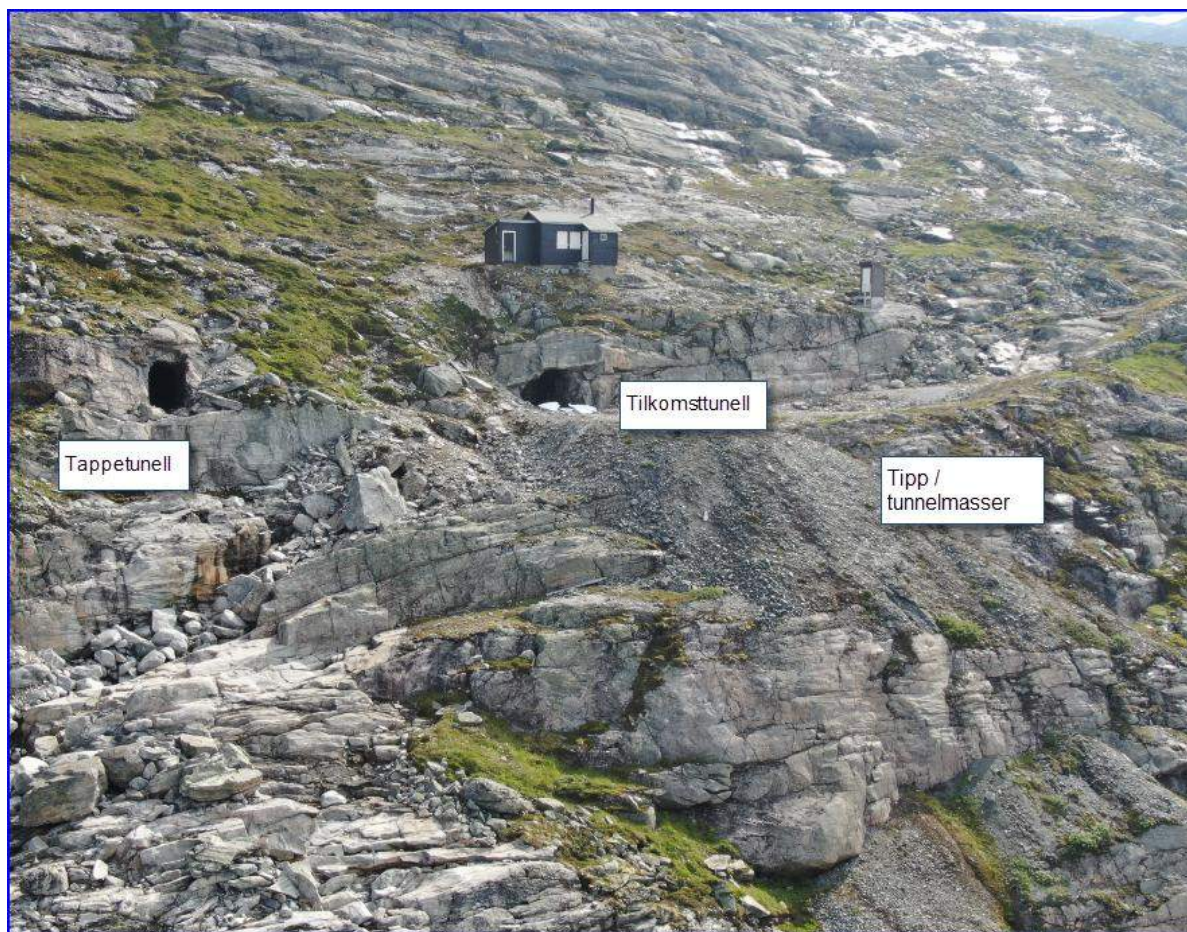
Figur. 3.5.5. Inngang til den gamle tappetunellen i Fetegga.
