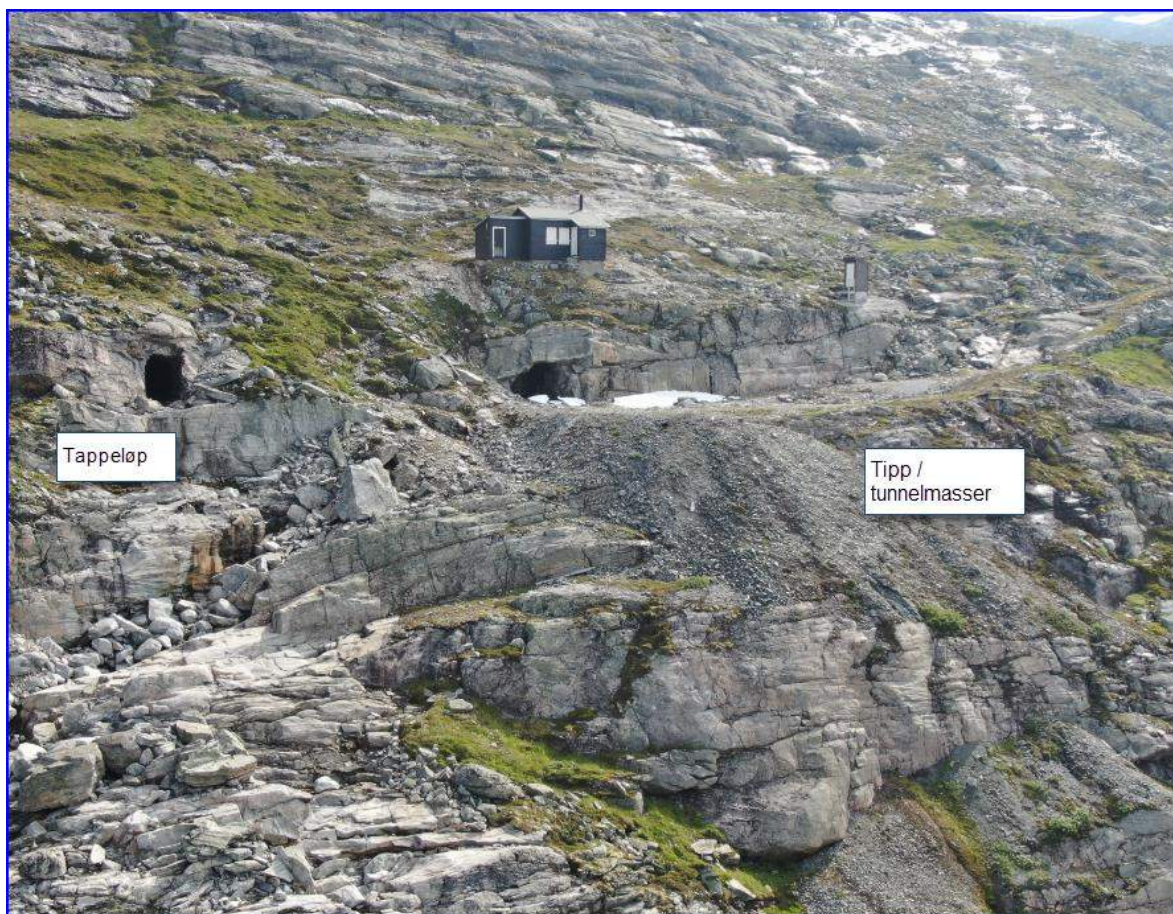
Foto 6 Dronefoto av driftstunnel og tappetunnel i Fetegga.
