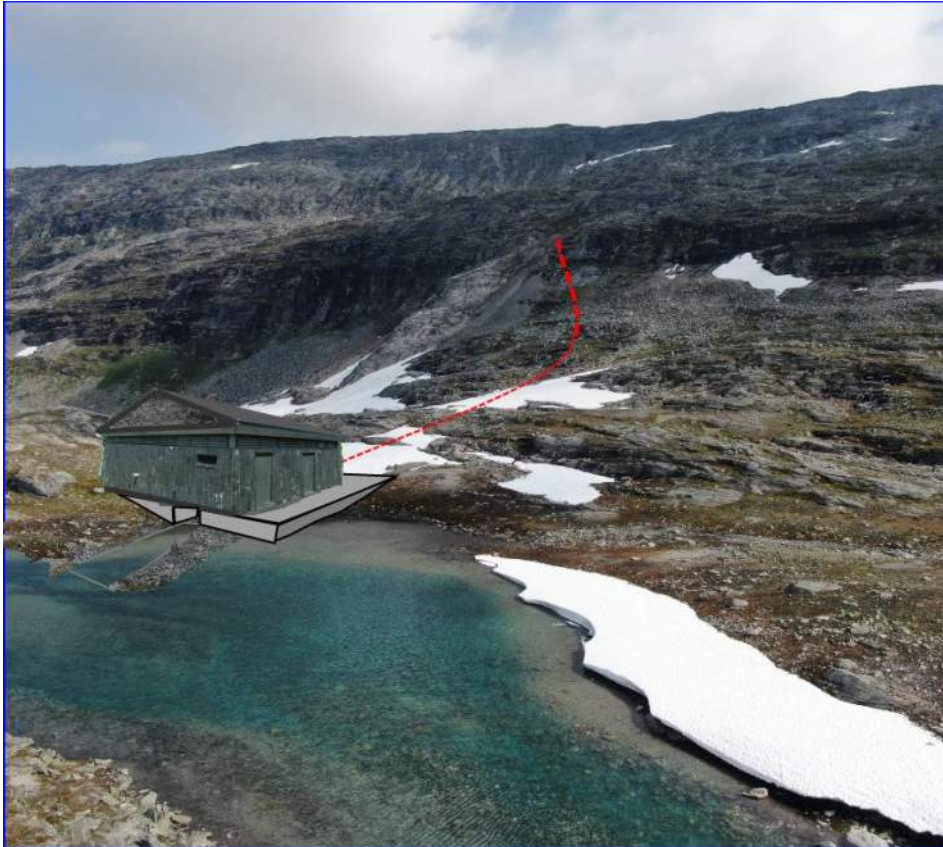
Foto 3 Fetegga pumpepestasjon (illustrasjon) og rørtrase opp mot tunnel i Fetegga
