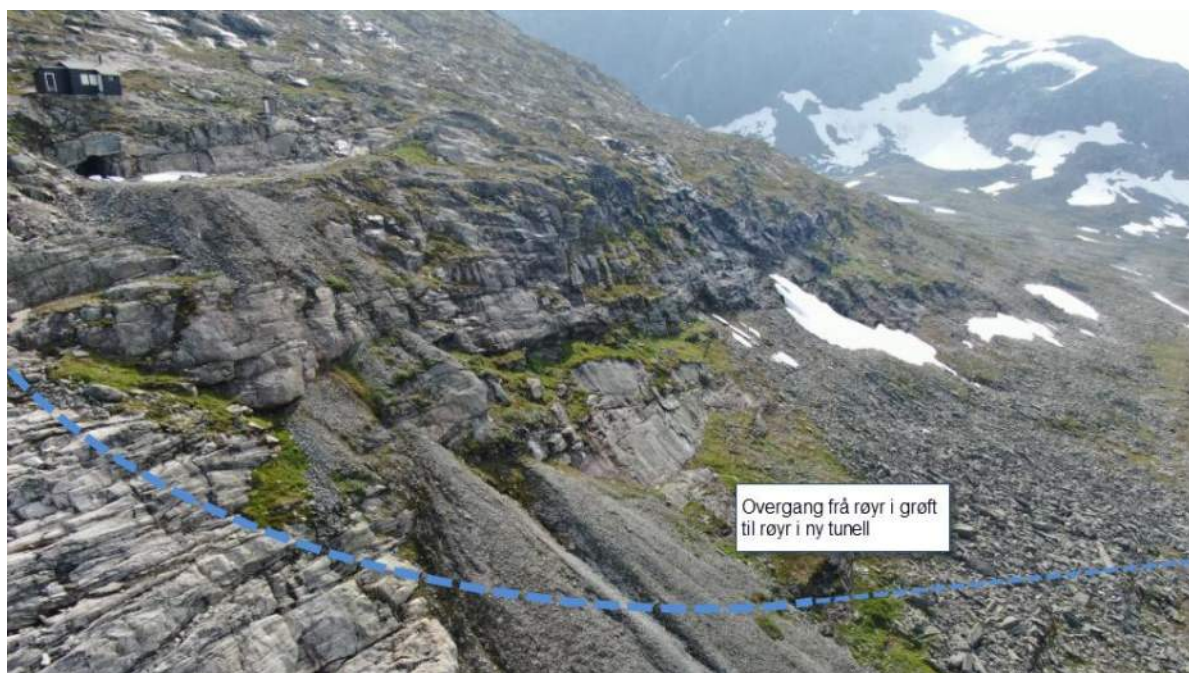
Figur. 3.5.2. Røyrtrase frå pumpestasjonen med overgang til tunnel vist i terrenget.
