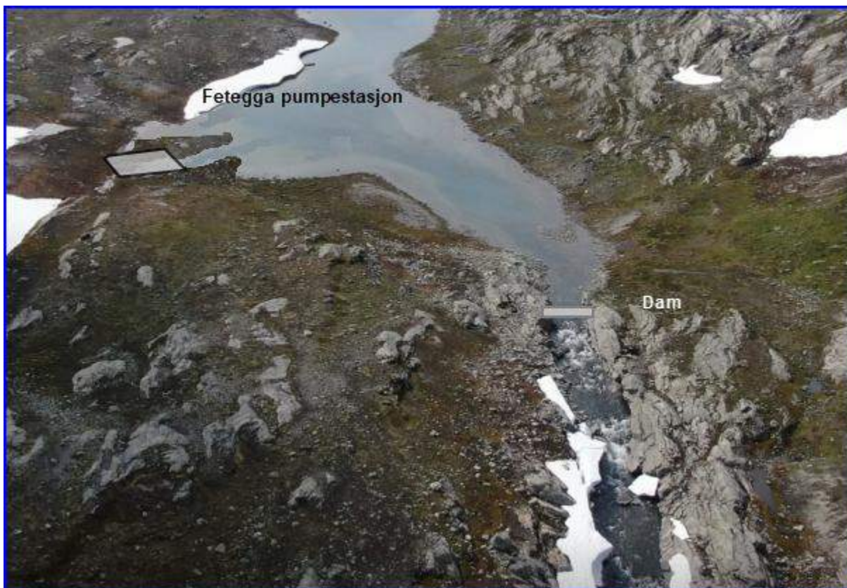
Figur. 3.5.6. Pumpehus med tilhørende kanal og dam i utløpet
