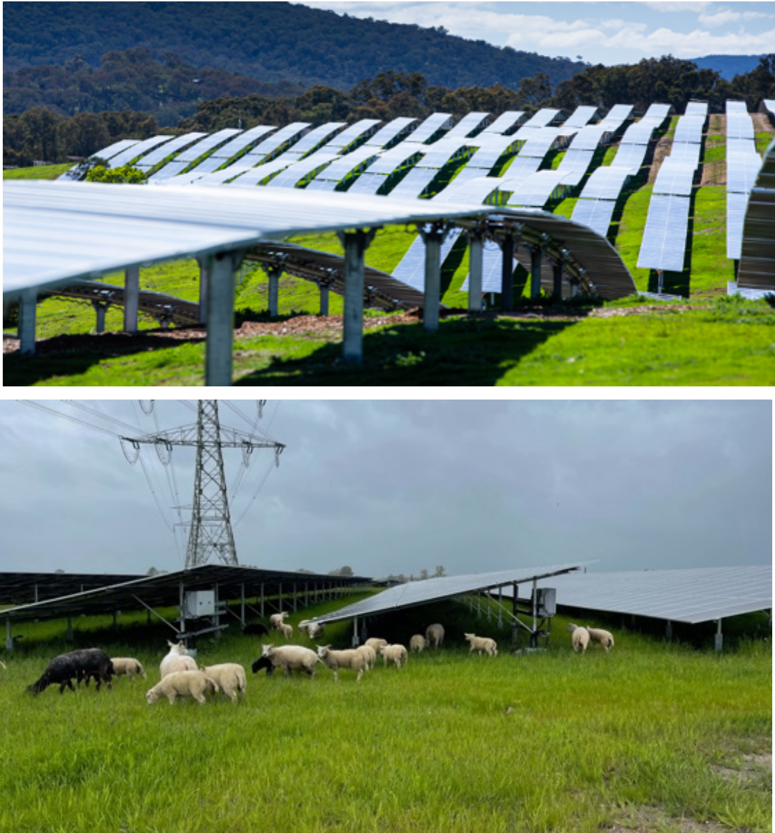
Figur 4: Illustrasjonsfoto én-akse følgestruktur og faststruktur. Kilde Nextpower og Energieia.
