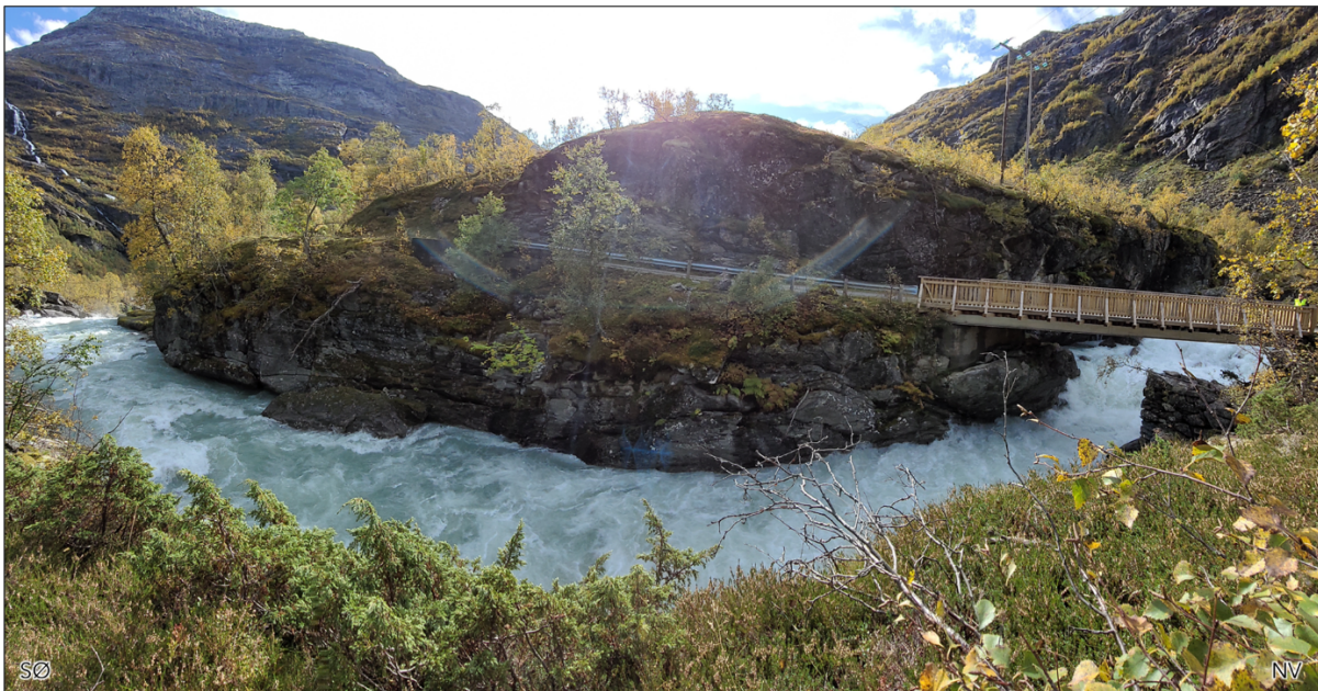
Figur 3-22: Panoramabilde for Tverrdalsbrui og gjelet videre nedstrøms, under moderat til høy vannføring under befaring i september 2023.
