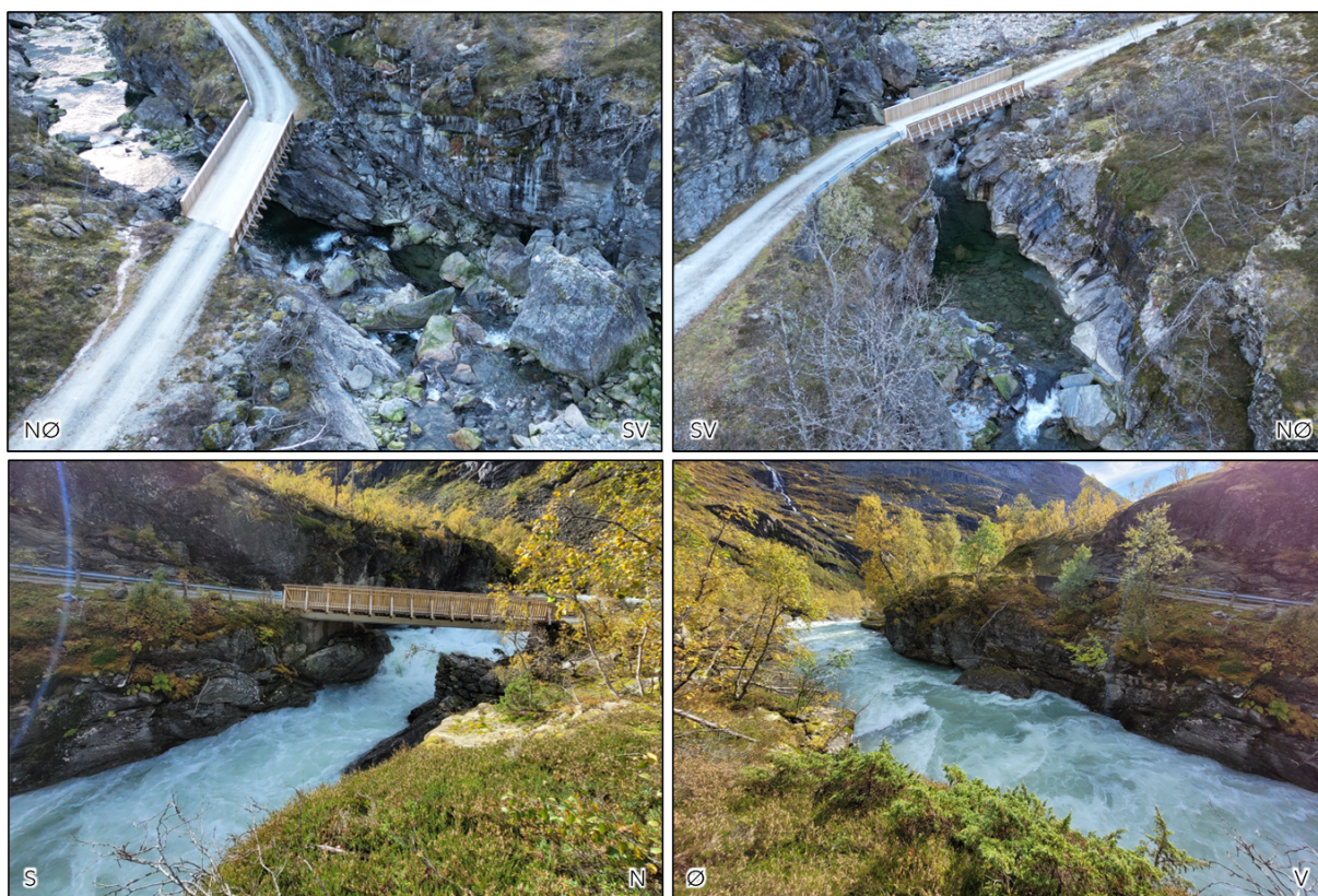
Figur 3-20: Bildeserie av Tverrdalsbrui på middels og lav vannføring. Dronebilder fra Hydro.
