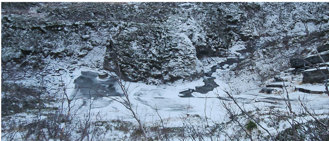
Inntaksområdet sett fra nord.
