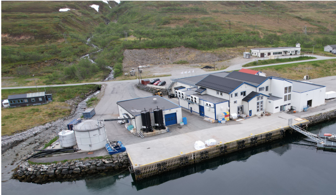
Fabrikk med elvedalen til venstre på bildet, inntakssted i oppe til venstre i bilde.
