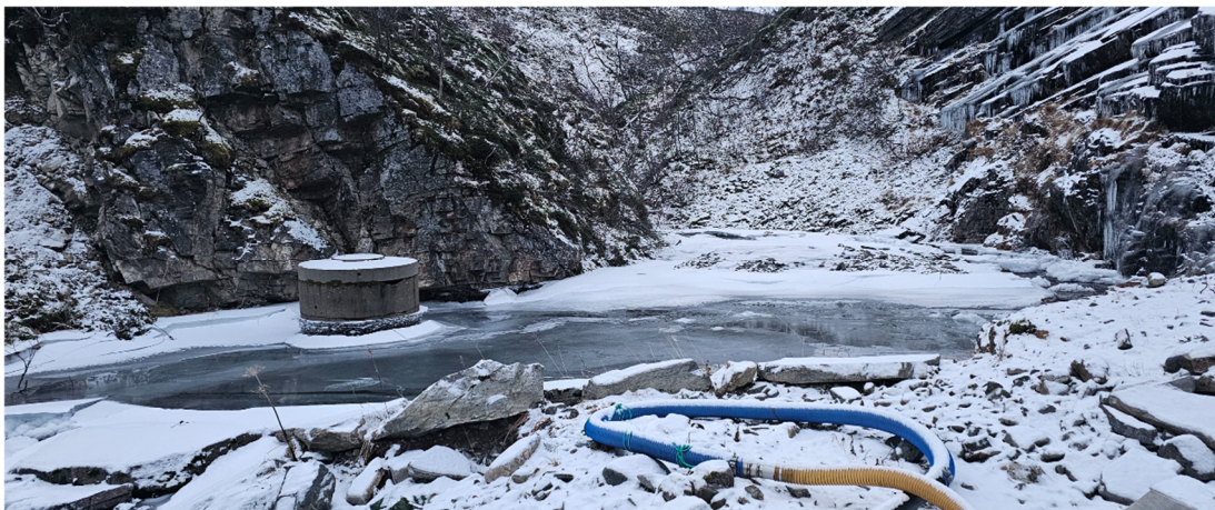
Inntaksområdet, men eksisterende dam og inntak, sett fra nedstrøms side.
