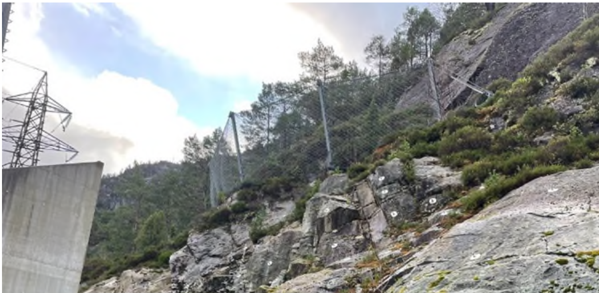
Figur 3: Biletet viser utførte sikringstiltak ved Lunden transformatorstasjon (2015)
