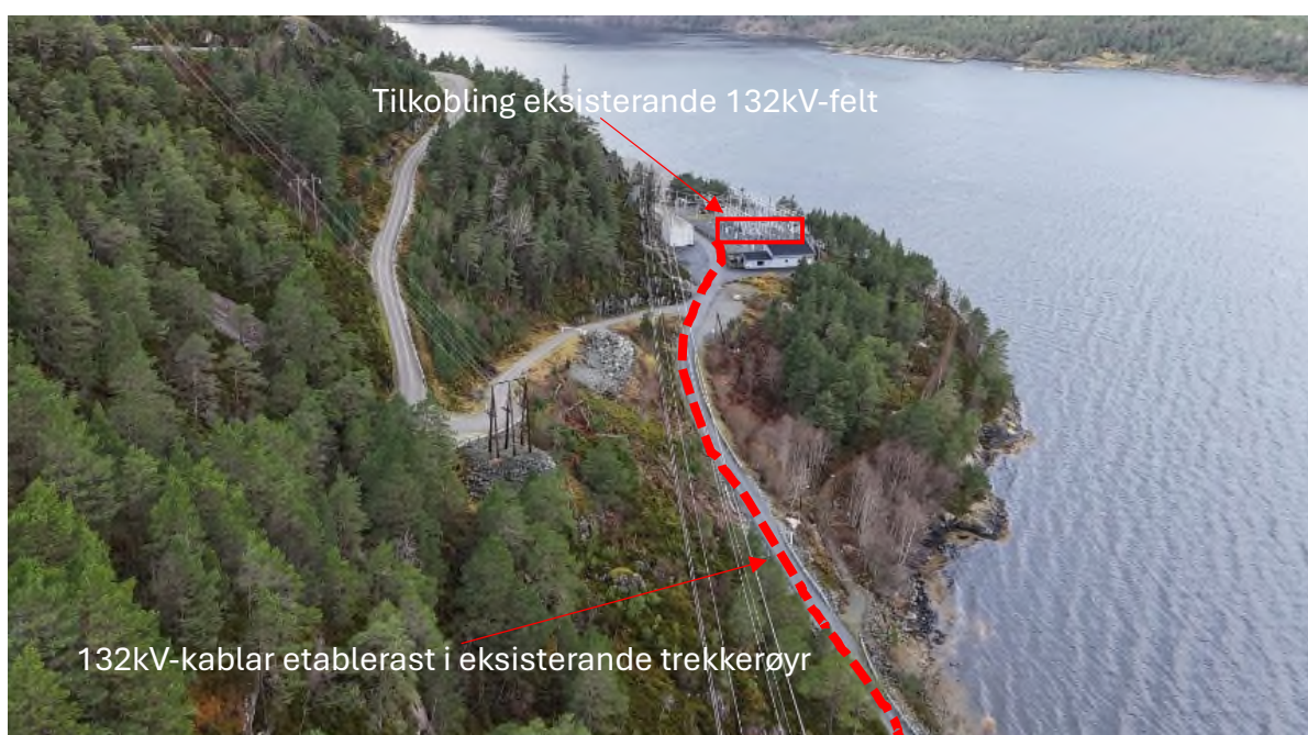
Figur 2: Biletet viser anleggsområdet frå aust mot vest påteikna ny kabeltrasé og felt for tilkopling til 132kV.
