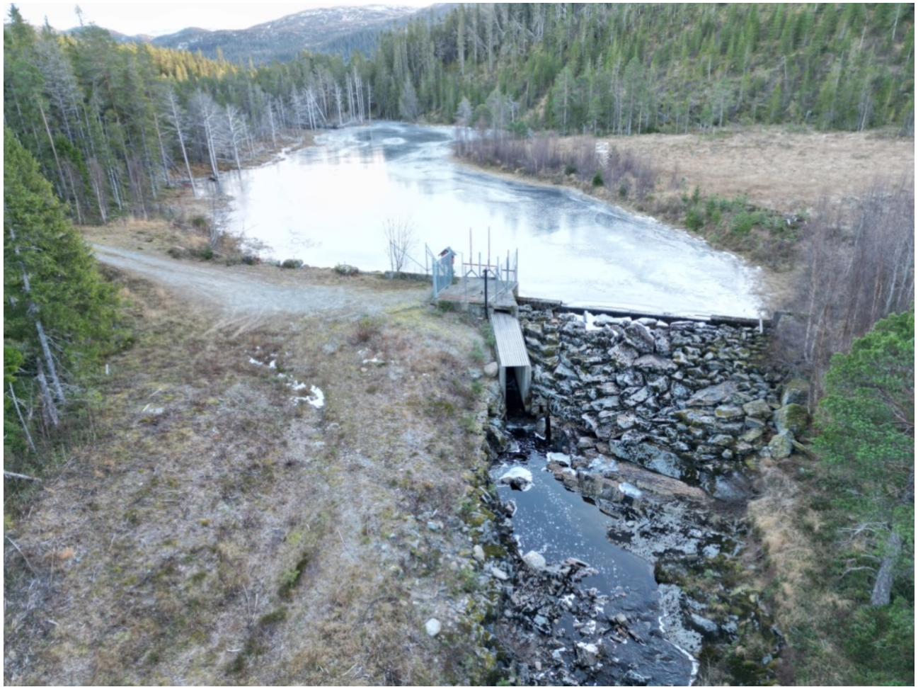
Figur 2 Dam og inntak
