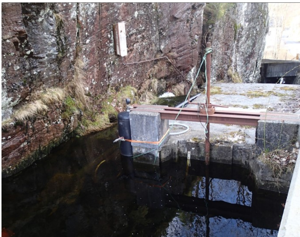
Figur 6. Utløpsdammen i Storavatnet (Tveitavatnet) men opprinnelig tappelupe, som ikke benyttes lenger. Dammen og tidligere tappeanordning er ikke helt tett, så anslagsvis 1-2 l/s lekker i dag gjennom dammen.
