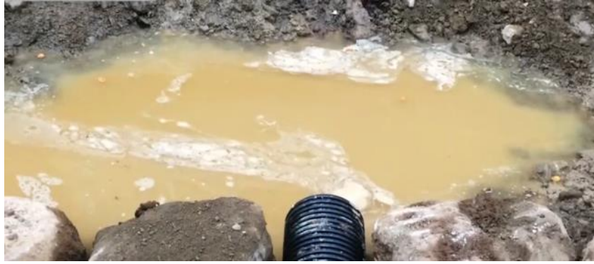
Figur 6. Sandfanggrop foran innløp stikkrenne
