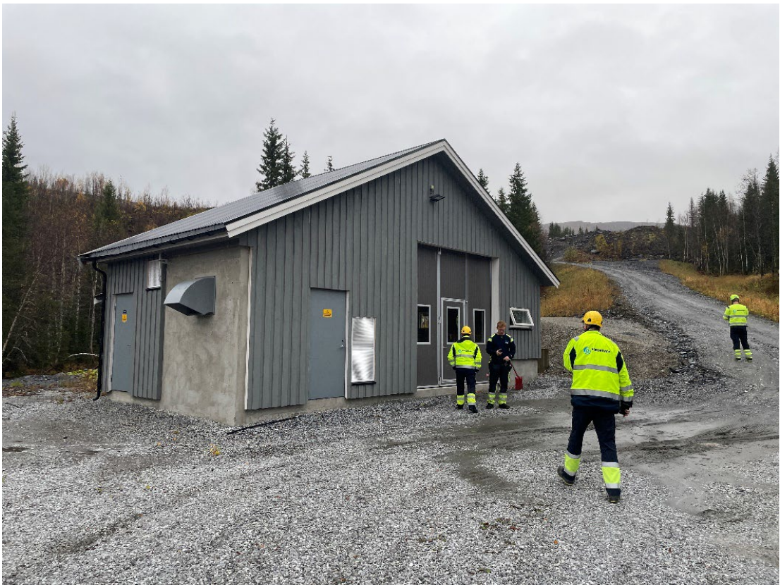
Figur 3 Laskbekken og Sakrisåga kraftstasjon, planlgges revet
