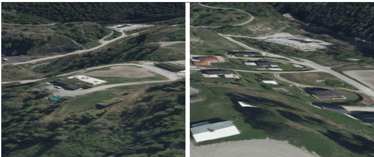
Bilde 6: 3D visualisering fra Kaggefossveien 551 (venstre), og fra boligområde i Messebakken (høyre), med utsiktsretning mot nye Kaggefoss koblingsstasjon. Kilde: NVE temakart.
