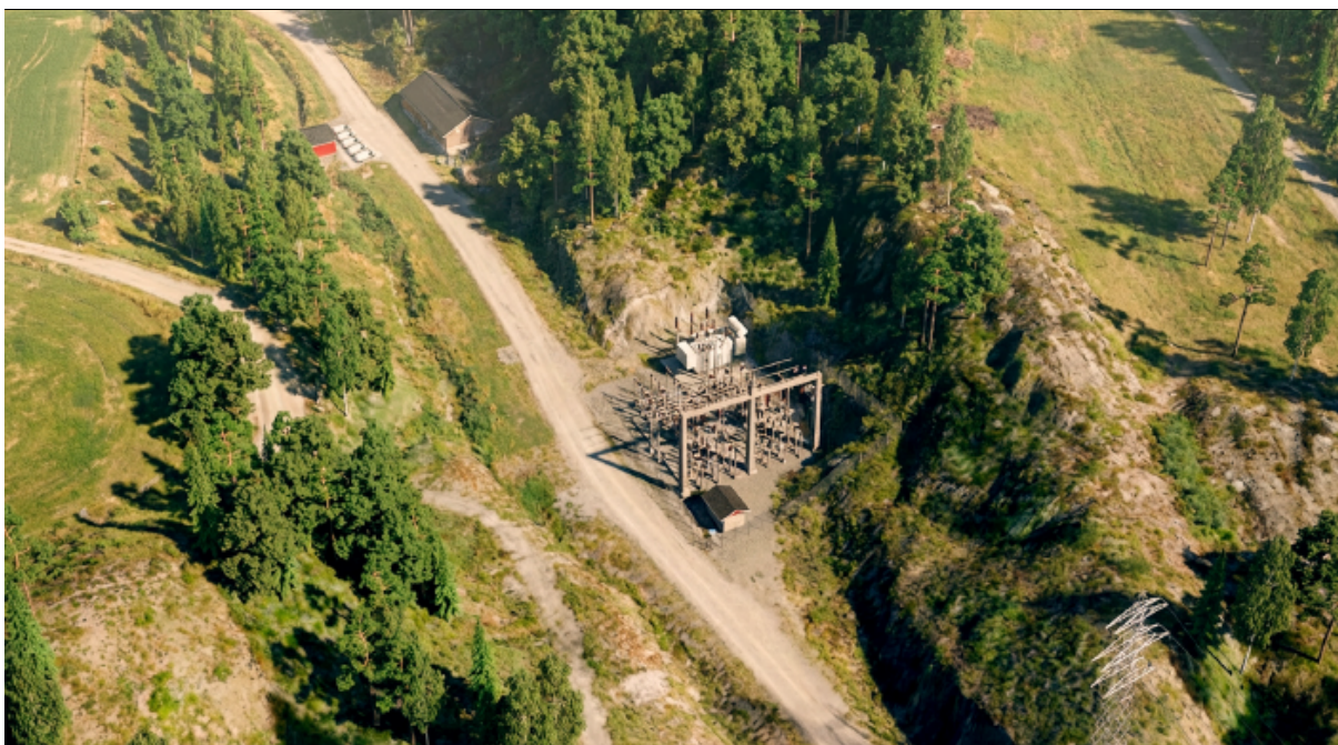
Bilde 3: Kaggefoss transformatorstasjon. Kilde: Konesjonssøknaden til Å Energi Vannkraft AS og Glitre Nett AS.
