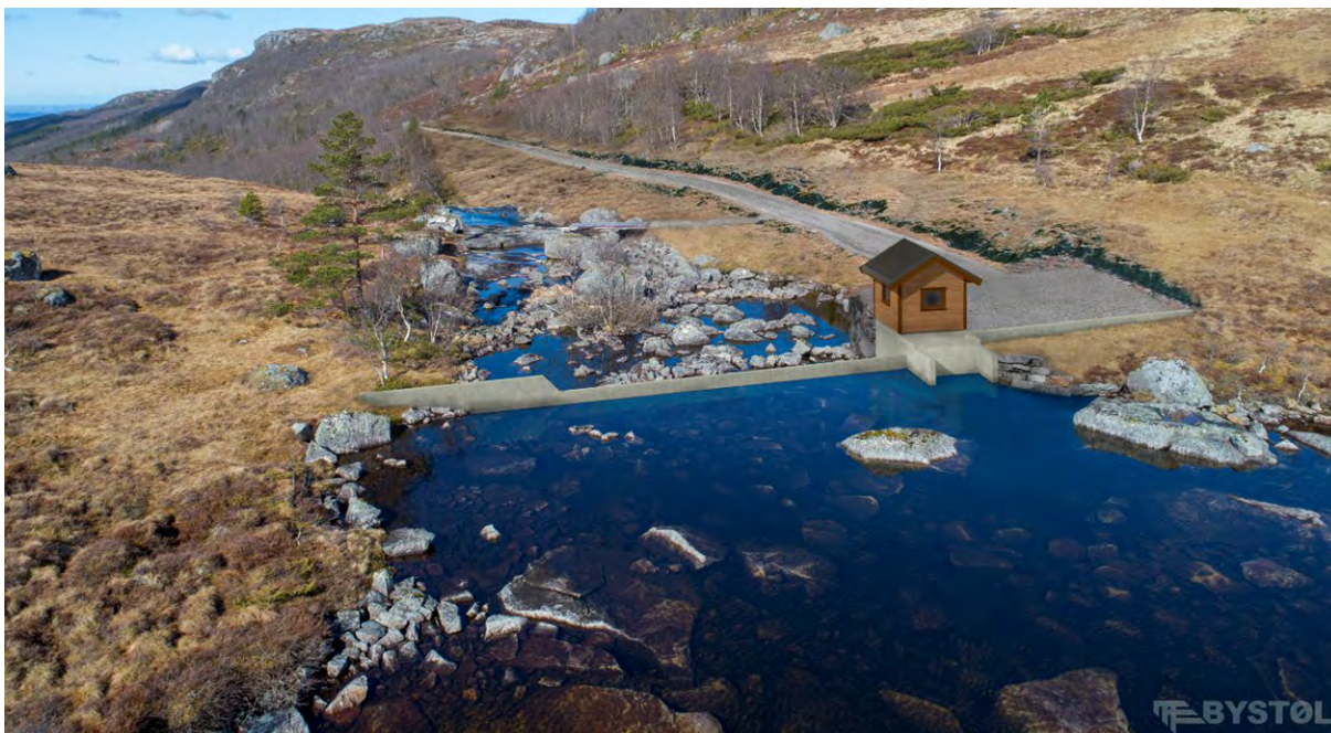
Bilde 3 - Vasspegel, tilkomstveg og inntakskonstruksjon illustrert i bilete
