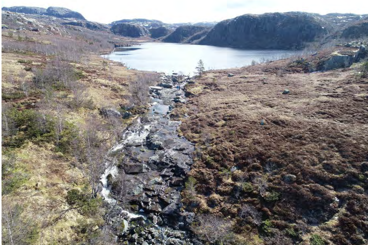
Bilde 1 - Kaldavatnet sett motstraums. Vassvegen vert nedgraven i skråninga langs elva til venstre i bilete.
