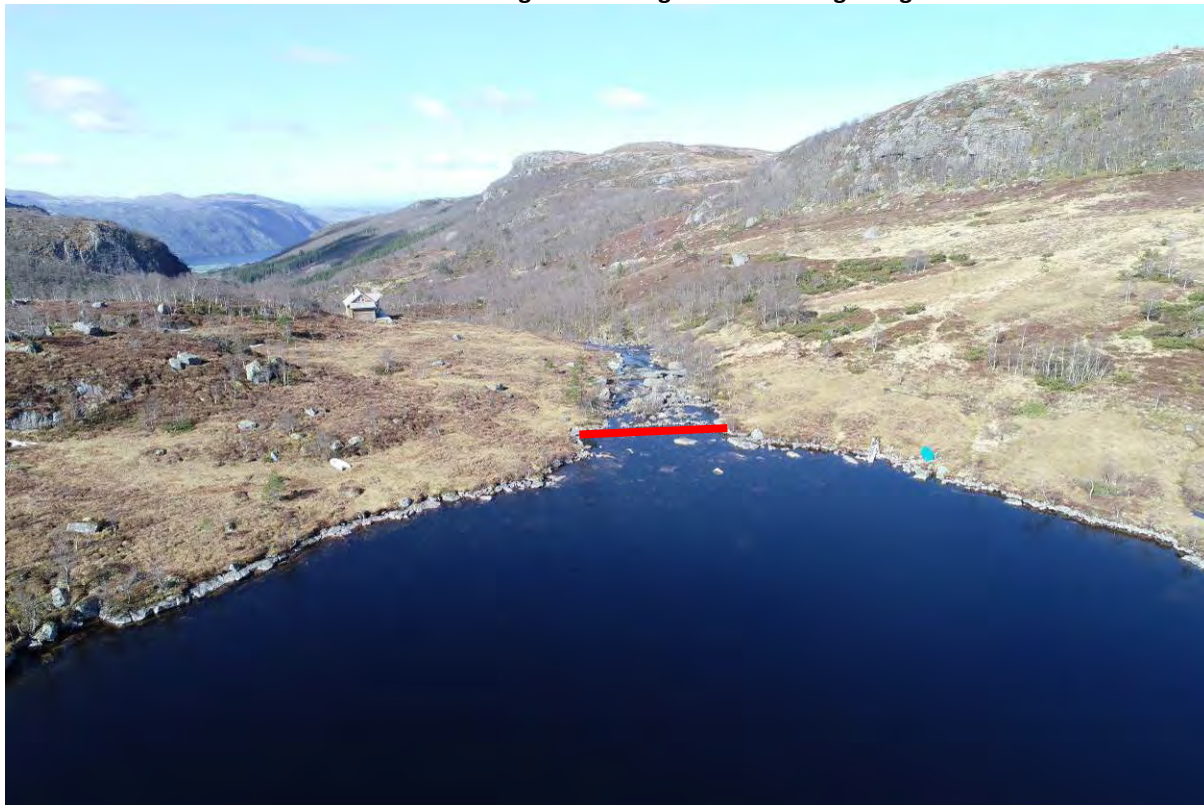
Bilde 2 - Dam-/inntaksområdet sett medstraums. Inntaket er planlagt midt i biletet markert med raud strek (Sjå fotoillustrasjon neste bilete).
