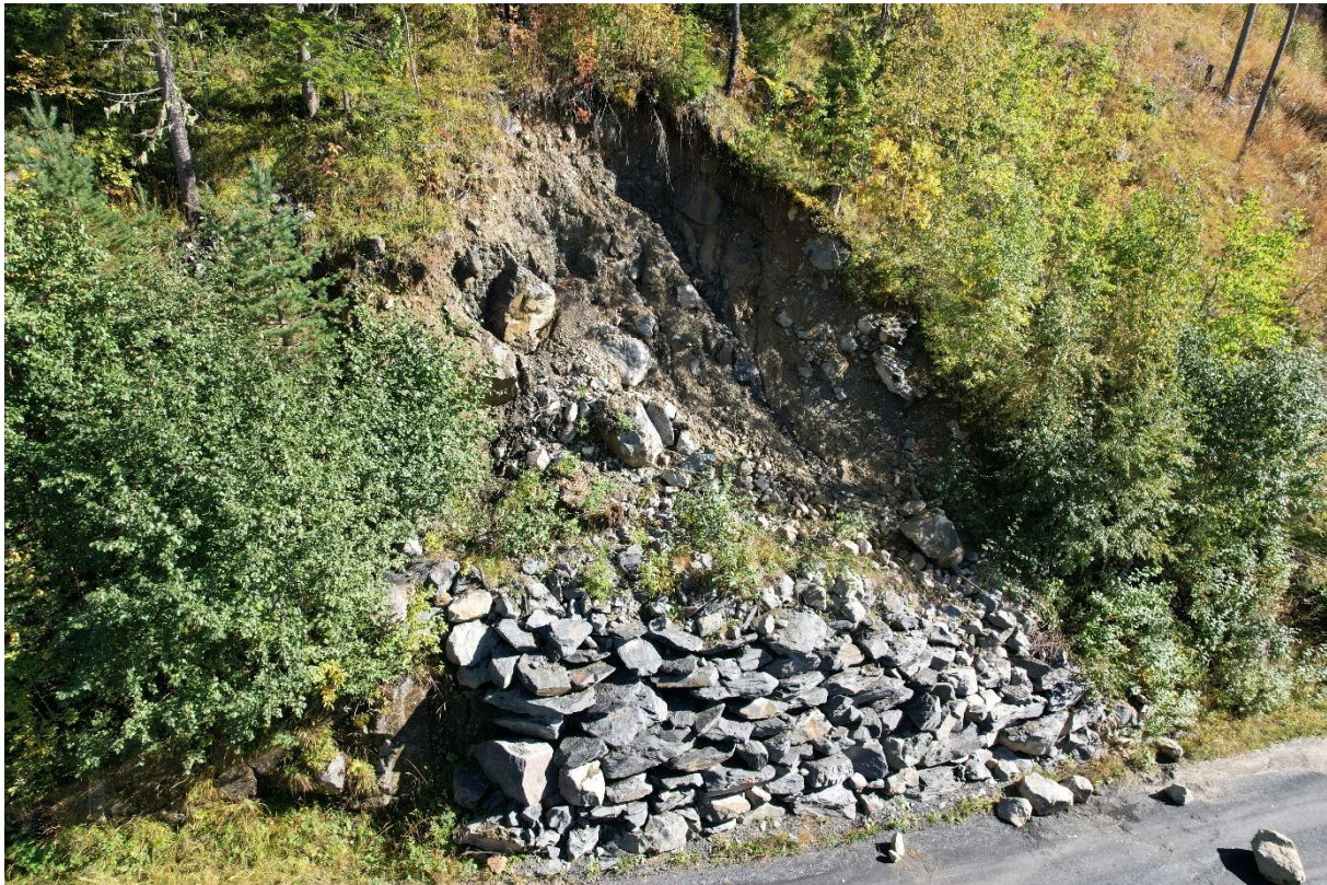
Figur 5: Skredsår i kjent skredpunkt langs Svilosvegen.
