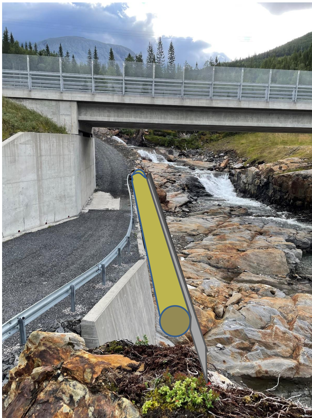
Figur 5 Rørgate under Ny E6 bru legges på innsiden av støpt murvegg (se illustrasjon over)
